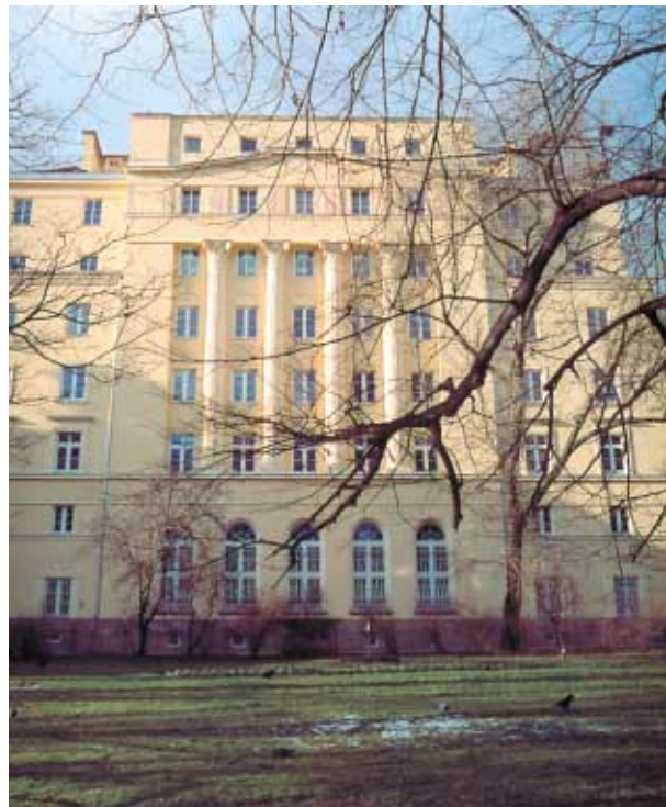
Akademia Muzyczna w Krakowie, elewacja wschodnia po renowacji
