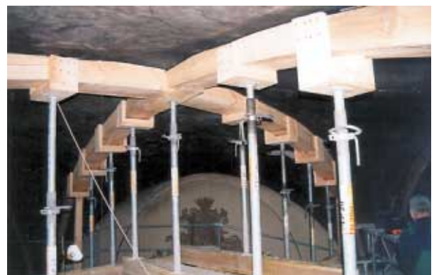
Fot. 14. Sposób podparcia sklepienia
