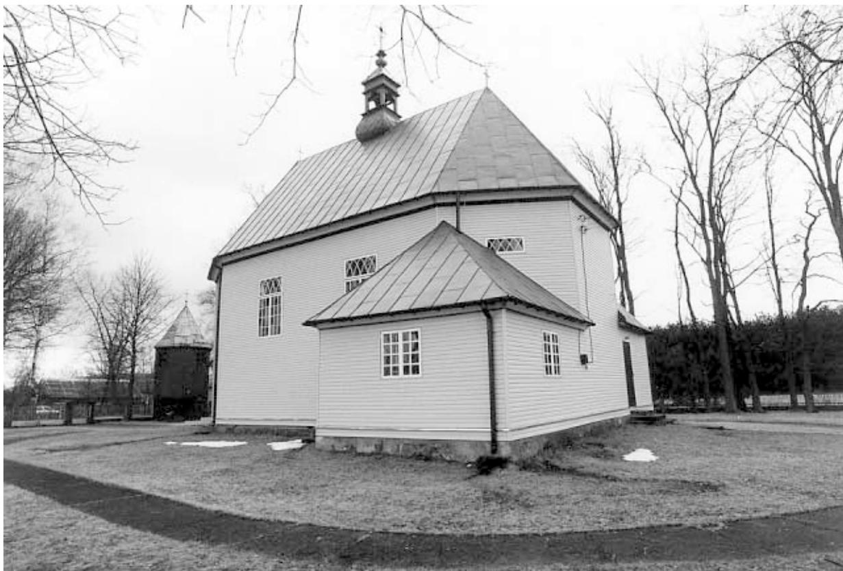
Zastosowanie nowoczesnego materiału wykończeniowego – sajdingu w obiciu ścian zewnętrznych kościoła w Olszewce, gm. Jednoróżec zniszczyło historyczną bryłę świątyni
