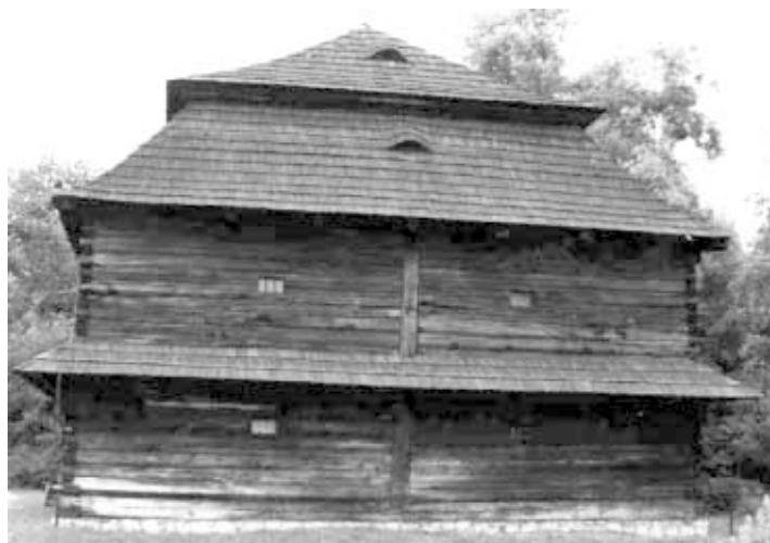
Ryc.14. Łątki w ścianie zrębowej. Spichlerz, Sławięcice, obecnie w Muzeum Wsi opolskiej, fot. autora
