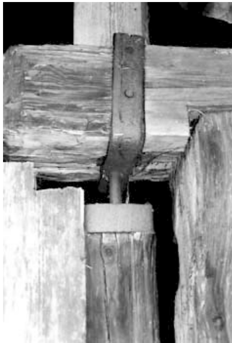
Ryc. 27. 1 – Biegun drewniany. Szopa na narzędzia, Kryry, fot. autora 2 – Biegun stalowy. Stoła, Brześć, fot. autora
