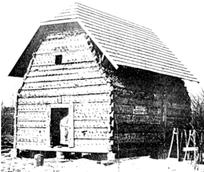
Ryc.5. Spichlerz z Głogówka w trakcie rekonstrukcji. Widok kołków przed obrzuceniem gliną, fot. ze zbiorów Muzeum Wsi Opolskiej
