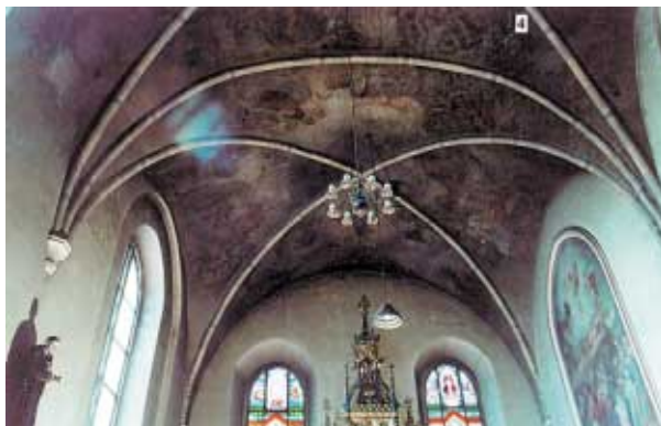
Fot. 1. Widok sklepienia od strony ołtarza
