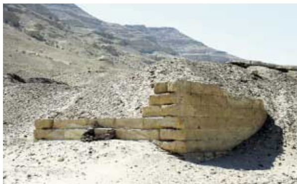
Rys. 10. Południowa wieża pylonu Physcona
