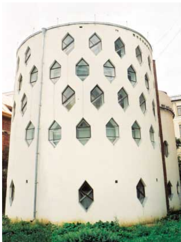
K. Mielnikow, dom własny, Moskwa 1927. Stan z 2002 r. Zdjęcie: B. Widera.
