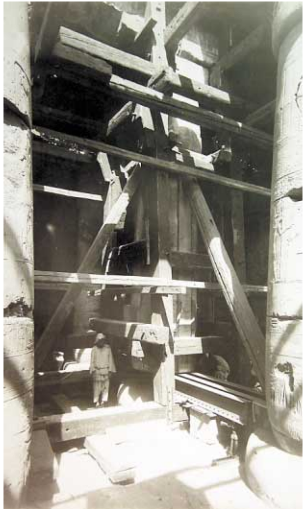
Rys. 17. Archiwalne zdjęcie z rekonstrukcji świątyni Setiego w Abydos
