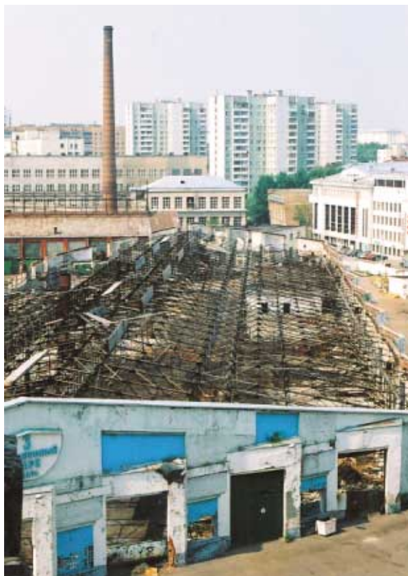
K. Mielnikow, „Bachmietewskoj garaż”, Moskwa 1926-27. Stan z 2002 r. Zdjęcie: B. Widera.
