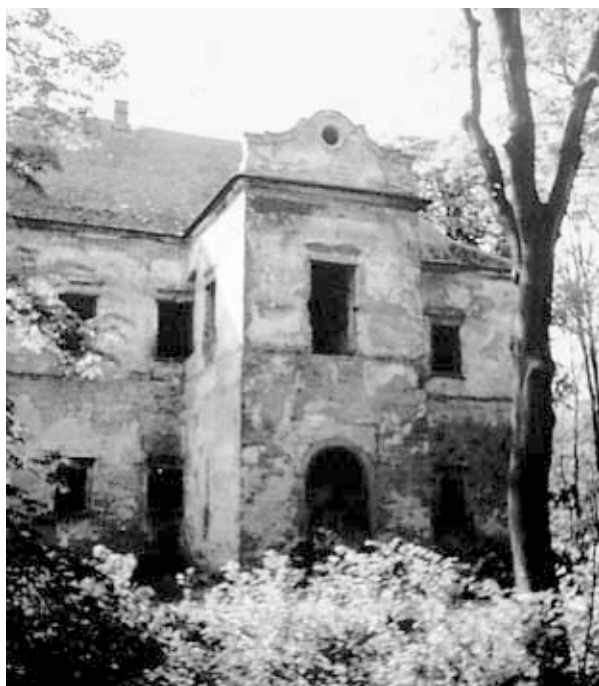
Rys. 5. Widok obecny dworu od frontu, fot. autorka, 2003
