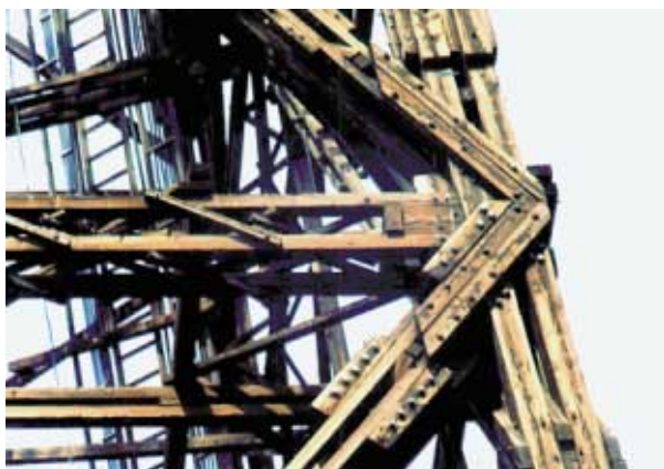
Rys. 1. Widok ogólny wieży oraz szczegóły konstrukcji
