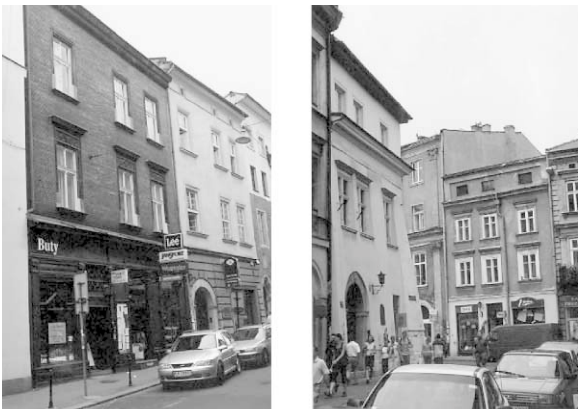
Rys. 6. Elewacje frontowe budynków przy ul. Szpitalnej 4, 6, Mikołajskiej 16 i św. Krzyża 7 powstałych na działkach półkuryjnych reprezentujące najczęściej realizowany typ krakowskiej kamienicy mieszczańskiej. Widoczny niesymetryczny układ osi elewacji będący wynikiem pierwotnego niesymetrycznego podziału gotyckiej sieni w przyziemiu.
