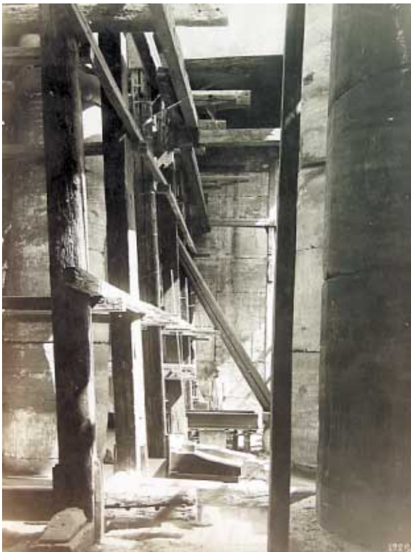
Rys. 16. Archiwalne zdjęcie z rekonstrukcji świątyni Setiego w Abydos
