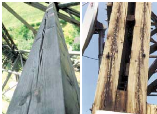
Rys. 4. Spękania podłużne prętów
