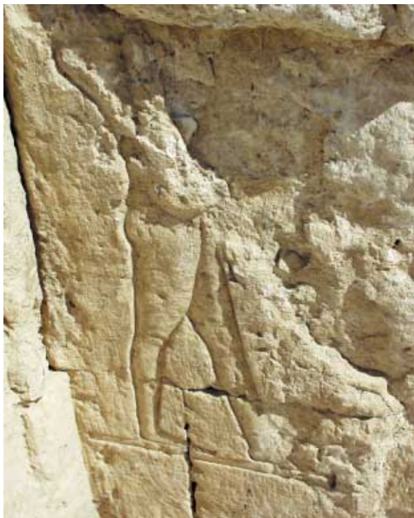
Rys. 19. Odszpajanie się wierzchniej, reliefowanej warstwy kamienia
