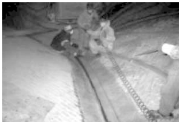
Rys. 12. Wzmocnianie żeber sklepień ceglanych w bazylice św. Franciszka w Asyżu za pomocą włókien węglowych
