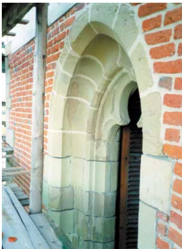
Rys. 7. Dzwonnica przy kościele farnym. Szczyt okna zach. Stan po wykonaniu flekowania i uzupełnieniu ubytków. Fot. Archiwum WO SOZ w Krakowie
