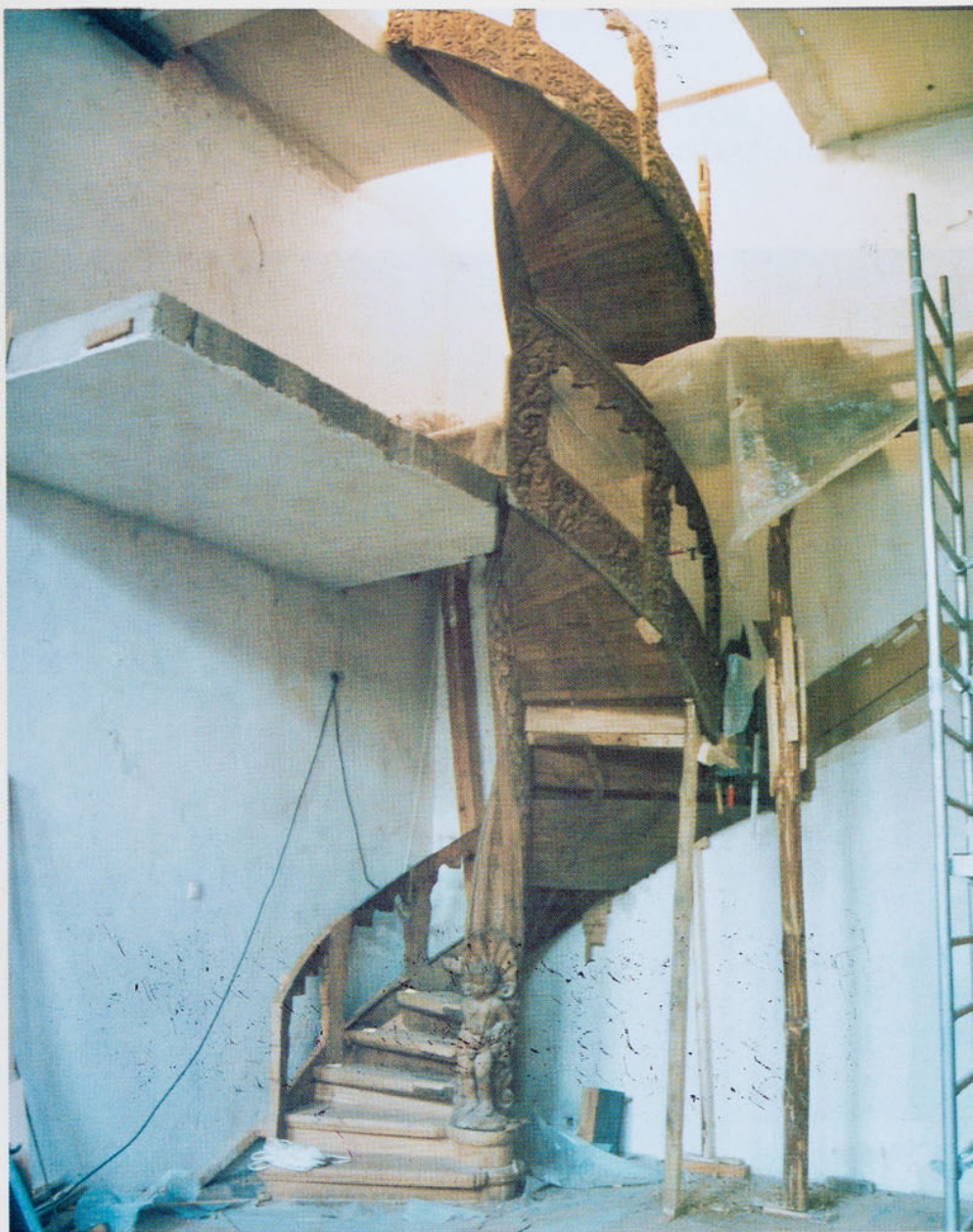
Sień Gdańska – początek montażu klatki schodowej.
