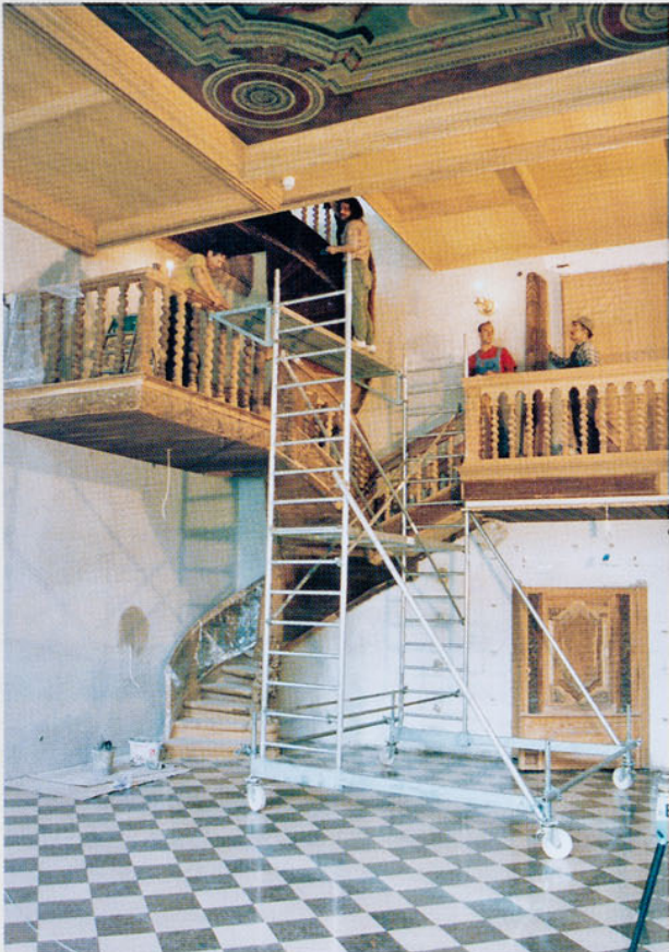
Sień Gdańska w trakcie prac konserwatorskich, fot. Beata Balcerzak
