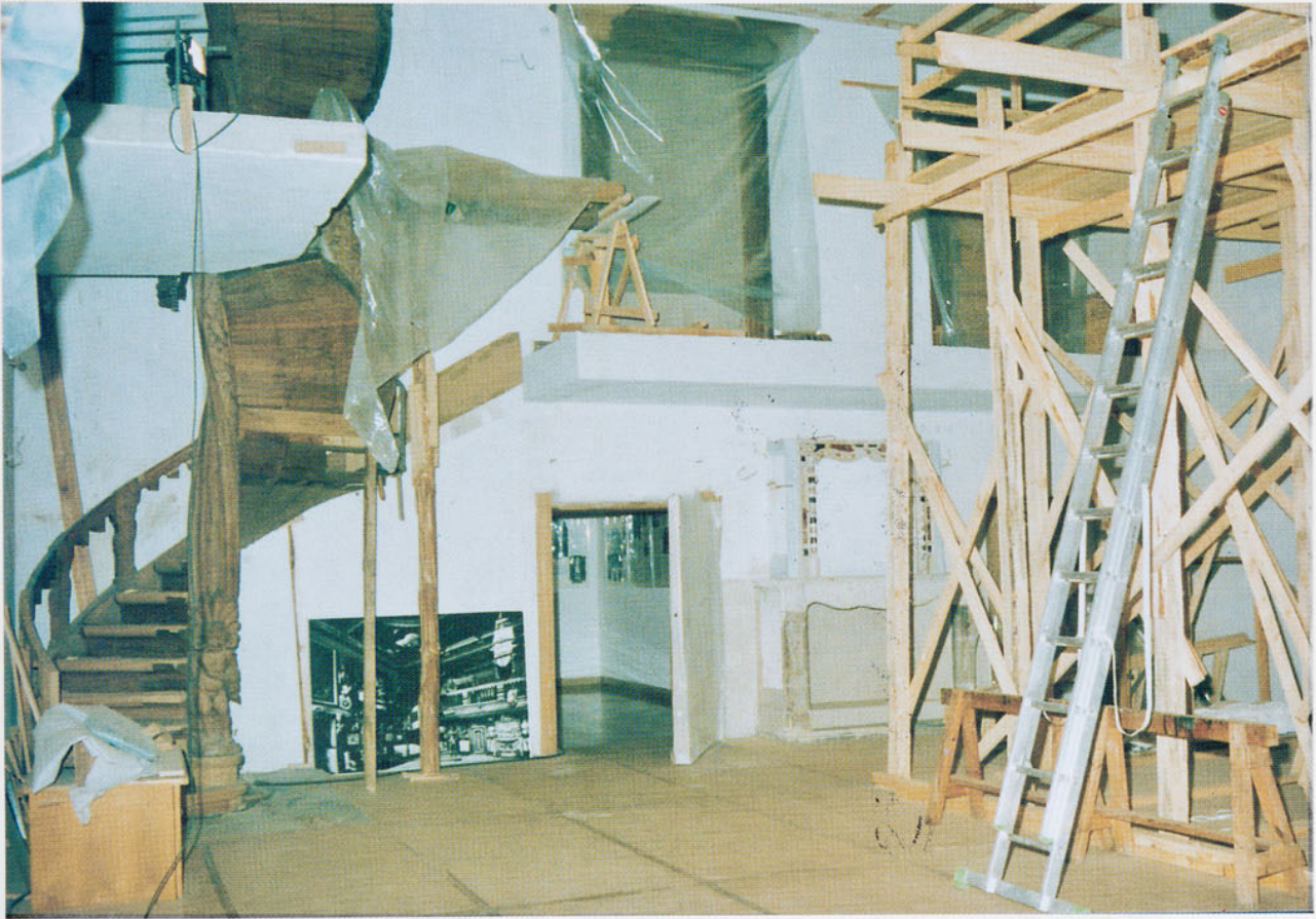
Sień Gdańska podczas prac budowlanych i konserwatorskich.
