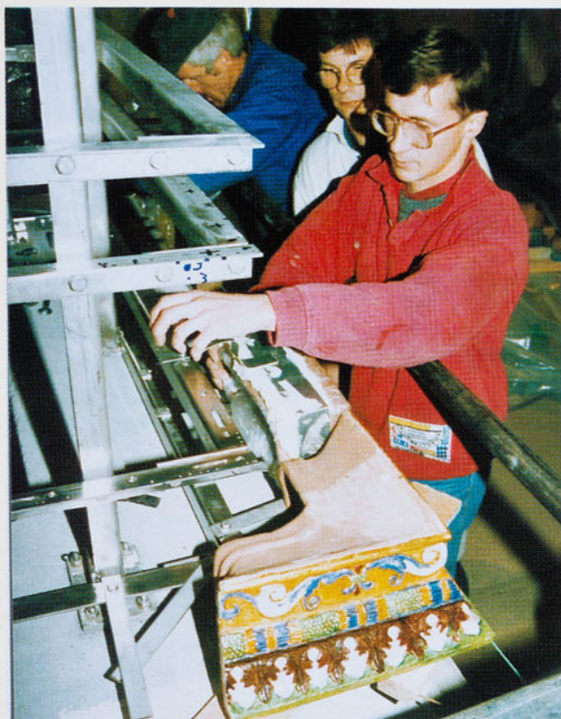
Wielki piec – montaż pierwszych kafli u podstawy pieca, fot. Beata Balcerzak
