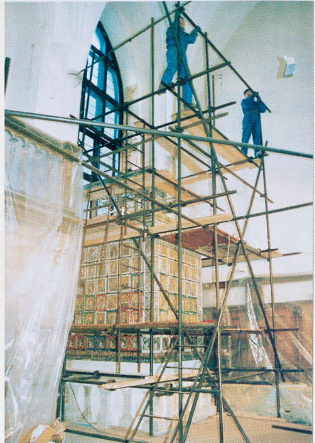
Wielki piec – prace przy II kondygnacji, fot. Beata Balcerzak
