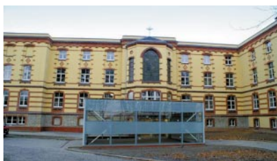
Widok budynku szpitala od południa, stan po generalnym remoncie, grudzień 2006. Fot. P. Gerber
