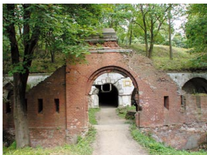
Ryc. 1. Wejście główne do fortu nr I
