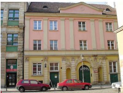
Ryc. 15. Wrocław, ul. Ofiar Oświęcimskich 3 – kamienica XVII-wieczna – 2. i 3. kondygnacja pozbawione w linii otworów okiennych architektonicznego wystroju – opasek okiennych, fartuchów, naczółków (fot. autor)
