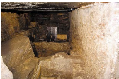
Zachowane relikty kamiennej budowli XIII-wiecznej w tzw. „Krzyżu Kramów Bogatych”
