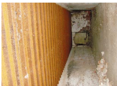
Ryc. 9. Fragment wnętrza fortu z widocznym stropem
