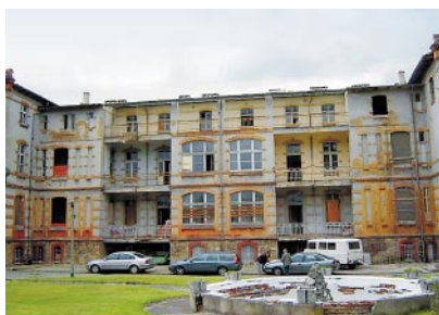
Widok budynku szpitala przed podjęciem prac remontowych, elewacja północna, listopad 2005. Fot. P. Gerber
