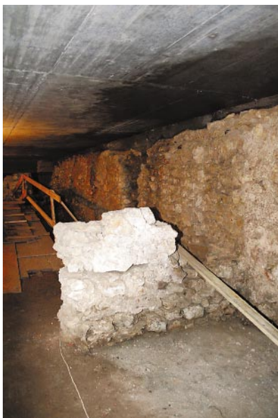
Mury Kramów Bogatych wykonane z łamanego wapienia jurajskiego
