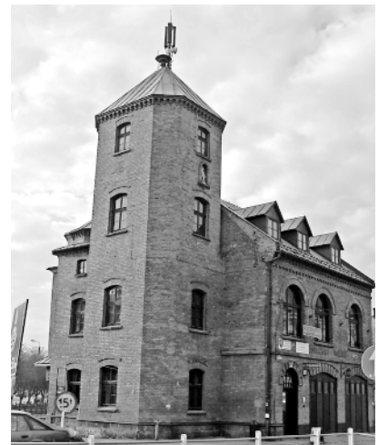
Ryc.6. Budynek straży pożarnej – narożnik południowo-wschodni – zdjęcie autora
