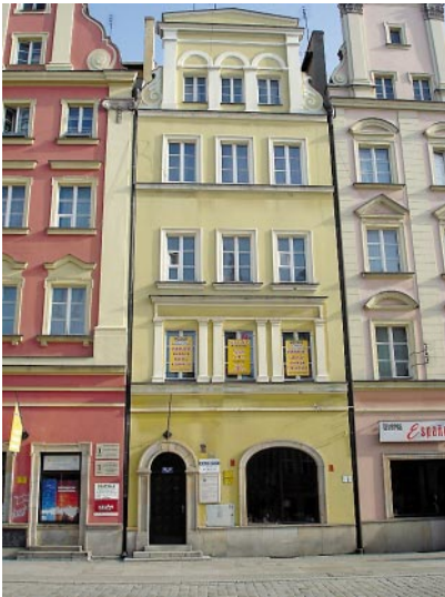
Ryc. 13. Rażąca biała kolorystyka ram okiennych oraz nieuzasadniona redukcja detali architektonicznego wystroju kamienicy nr 56/57 przy wrocławskim Rynku w pierzei pñ. (fot. autor)
