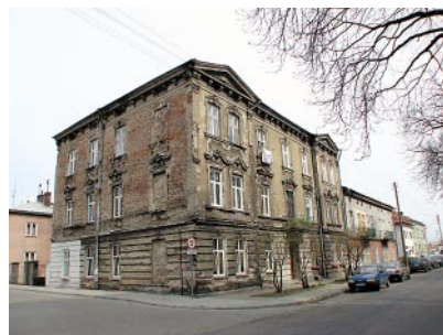
Ryc. 12. Budynek dowództwa Twierdzy, widok ścian z resztkami dekoracji plastycznych
