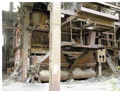
Elektrownia na Kazimierzu. Hala kotłowni. Na pierwszym planie silosy na węgiel, w głębi pozostałości kotła Babcock-Wilcox. Stan obecny. Fot. autor
