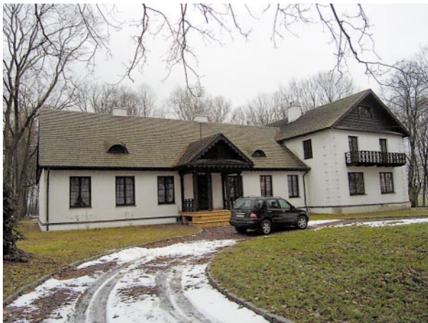
Ryc. 3. Elewacja frontowa drewnianego dworu w Leścach Fig. 3. The front elevation of the wooden manor house in Leśce
