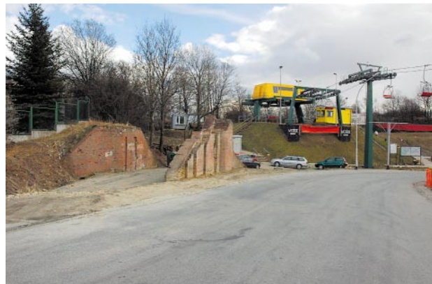
Ryc. 6. Fragment parku sportowo-rekreacyjnego, widok na bramę forteczną przy ul. L. Pasteura, stan obecny Fig. 6. Fragment of the sports and recreation park, view of the fort gate in L. Pasteur Street, current state
