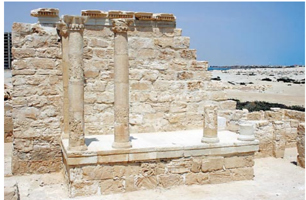
Ryc. 11. Marina El-Alamein. Dom H21c. Pomnik Komemoratywny w 2007 r. po zakończeniu częściowej anastylozy i prac konserwatorskich (fot. R. Czerner) Fig. 11. Marina El-Alamein. House 21c. The Commemorative Monument in 2007, after completing partial anastylosis and conservation work (photo: R. Czerner)
