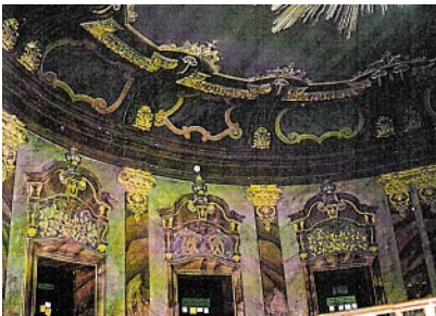
Ryc. 3. Neobarokowe wnętrze klatki schodowej – stan przed konserwacją Fig. 3. Interior of the Neo-Baroque staircase – before conservation
