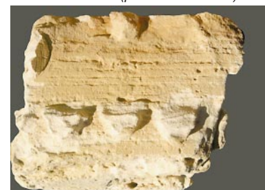
Ryc. 6. Marina El-Alamein. Dom H21c. Pseudokoryncki kapitel kwadratowego w planie pilastra Pomnika Komemoratywnego. Stan przed konserwacją (fot. R. Czerner) Fig. 6. Marina El-Alamein. House 21c. Pseudo-Corinthian capital of the square pilaster from the Commemorative Monument. Before conservation (photo: R. Czerner)
