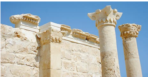
Ryc. 12. Marina El-Alamein. Dom H21c. Góra część Pomnika Komemoratywnego w 2007 r. po zakończeniu częściowej anastylozy i prac konserwatorskich (fot. R. Czerner) Fig. 12. Marina El-Alamein. House 21c. The upper part of the Commemorative Monument in 2007 after completing partial anastylosis and conservation work (photo: R. Czerner)
