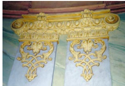
Ryc. 6. Wnętrze neobarokowej klatki schodowej – stan po konserwacji Fig. 6. Interior of the Neo-Baroque staircase – after conservation
