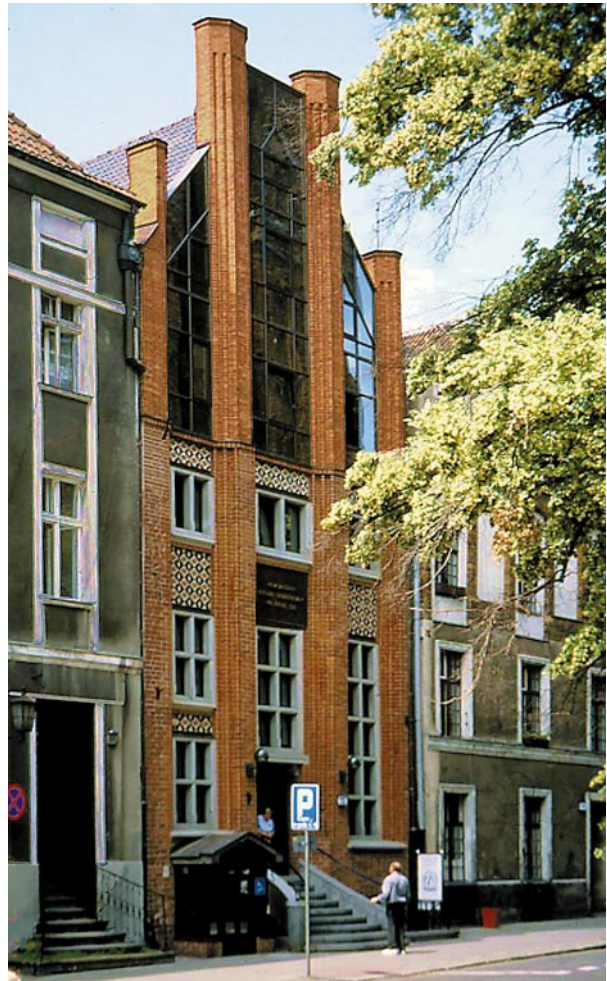
Ryc. 4. Toruń. ul. Żeglarska 13 Dobry przykład współczesnej interpretacji niezachowanego szczytu, dzięki wyważonej proporcji szkła w stosunku do ceglanych lizen. Nie ma tu przysłowiowej „dziury”. Zastrzeżenie może budzić jedynie ceglana rolka zastosowana w lizenach sugerując, iż tu mogły się one kończyć. Fig. 4. Toruń. 13 Żeglarska Street. A good example of modern interpretation of a destroyed gable, owing to balanced proportion of glass and brick lisenes. There is no proverbial 'hole' here. The only objection could be raised because of the use of brick rolls in the lisenes which suggests that they might have ended here.
