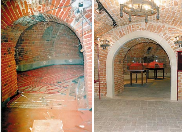
Ryc. 1. Zamek w Dzikowie. Piwnica 1, przed i po remoncie Fig. 1. Dzikow castle. Cellar 1, before and after the renovation
