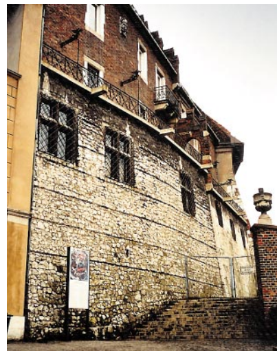
Ryc. 3. Wawel – dom Wikariuszów; widok z zewnątrz Fig. 3. Wawel – Curates' House; view from the outside
