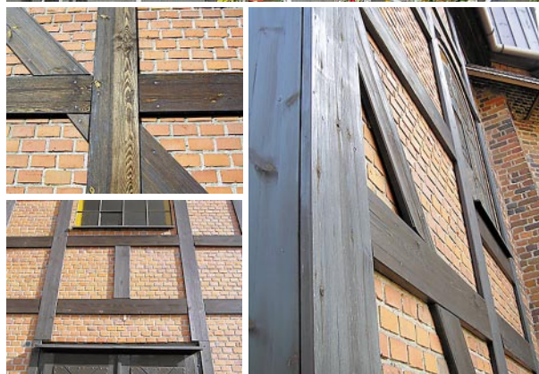
Ryc. 12. Przykłady wymiany i dekorowania detalu drewnianych kościołów Wielkopolski Drewniane świątynie patynowały się równomiernie i nie miały kolorowych „falbanek” ani „kapliczek”, jak to widać na lewym zdjęciu u góry (przedstawiającym kościół z XVII w. w Przypuszcie k. Nieszawy). Fig. 12. Examples of replacing and decorating the details of wooden churches in Greater Poland. Wooden churches covered with patina evenly and did not have colourful “frills” or “chapels” as can be seen on the top left photo (depicting a church from the 17th century in Przypust near Nieszawa).
