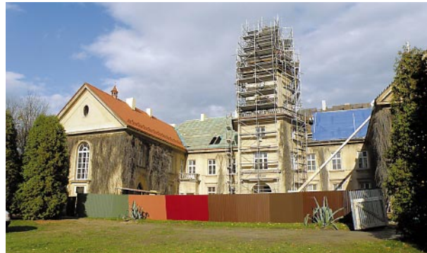
Ryc. 5. Zamek w Dzikowie. Remont konserwatorski dachu Fig. 5. Dzikow castle. Conservation and renovation of the roof
