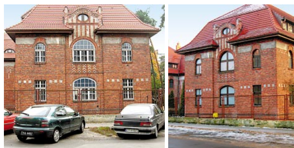
Ryc. 13. Toruń. ul. Słowackiego 45 Dawny tzw. szpital obywatelski z 1907 r. (potem przekształcony na internat szkolny) został zaadaptowany na dom księży emerytów. Zdjęcie po lewej przedstawia elewację z oryginalnymi oknami szczeblinowymi malowanymi na biało. Zmieniono je na ciemne bez podziałów po prawej) niszcząc unikatową kompozycję secesyjną („staraniem” gospodarza ks. prałata J. Kwaśniewskiego). Jest to kolejny przykład degradacji dziedzictwa architektonicznego, przykro, że pochodzi z tak zacnej instytucji. Fig. 13. Toruń. 45 Słowackiego Street. The old so-called citizen hospital from 1907. (later converted into a school dormitory) was adapted for a residence for retired priests. The photo on the left depicts the elevation with original muntin windows painted white. They were replaced with the dark ones without the dividing muntins (on the right) thus destroying the unique Secession composition (by the ‘efforts’ of the host, the Prelate rev. J. Kwaśniewski). It is yet another example of degradation of architectural heritage; pity, that it comes from such a decent institution.
