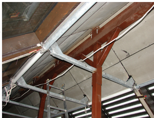
Rys. 5. Wykonane wzmocnienie dachu Fig. 5. Roof ridge after strengthening
