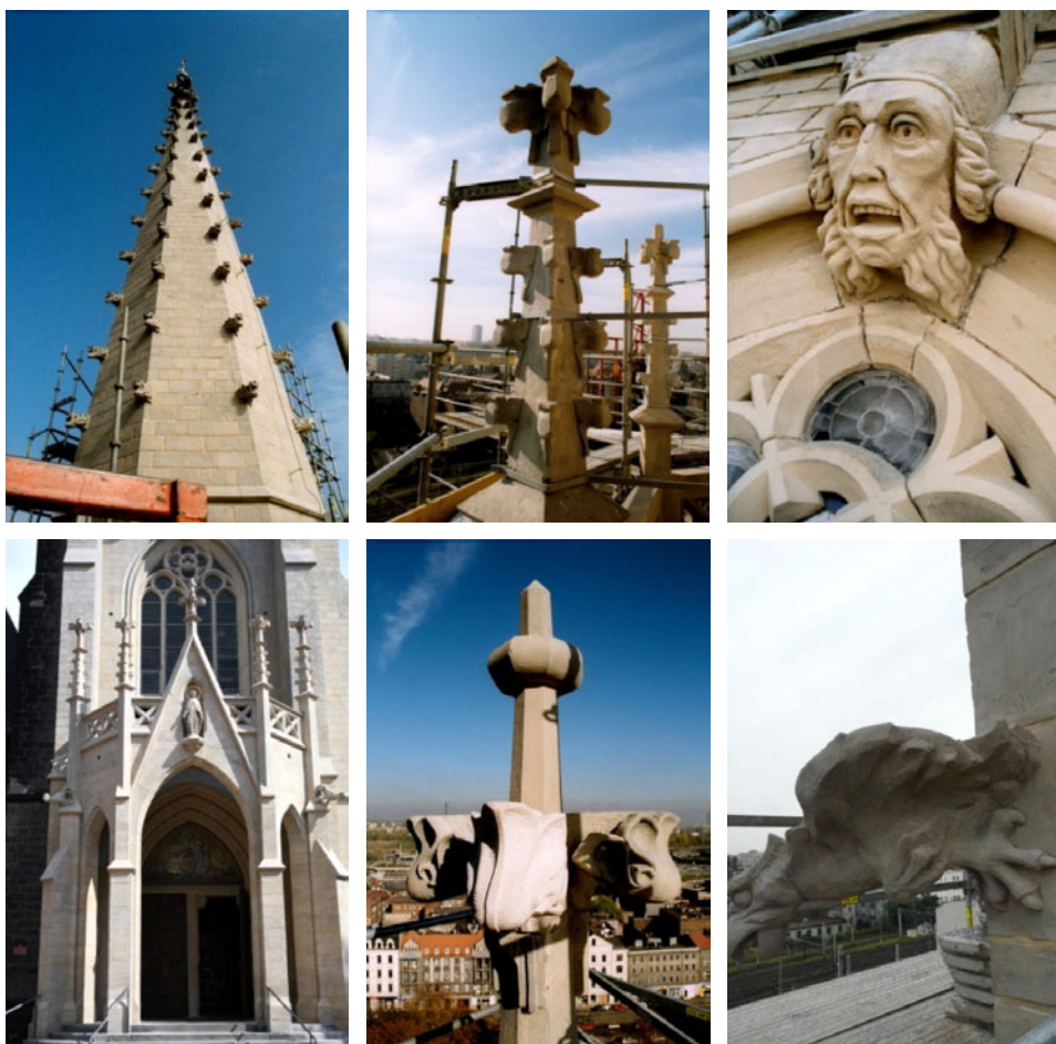
Rys. 11. Szczegóły elewacji po przeprowadzeniu prac renowacyjnych Fig. 11. Details of the renovation works
