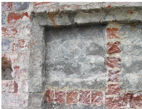
Rys 5. Brzeg, Sukiennice 5, średniowieczna blenda z imitacją oszklenia na romb – górne kwatery blend. Foto A. Peszko Fig 5. Brzeg, 5 Sukiennice, a medieval blind window with imitation of rhomboid glazing – upper panels of the blind window. Photo: A. Peszko
