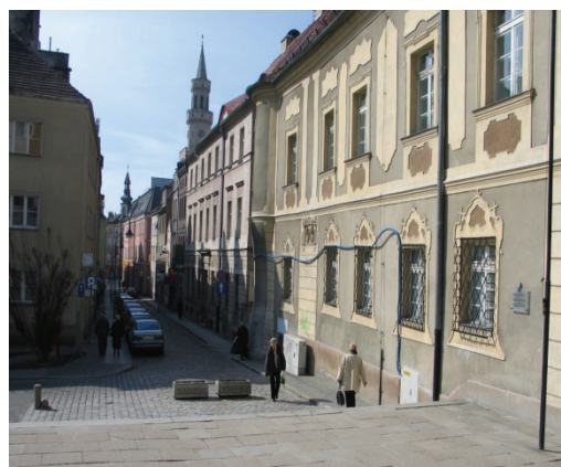
Widok frontu budynków wskazany strzałką – widoczne są (od prawej): BW, BA i KM Front walls of the buildings indicated by an arrow – BW, BA i KM are seen (from the right)
