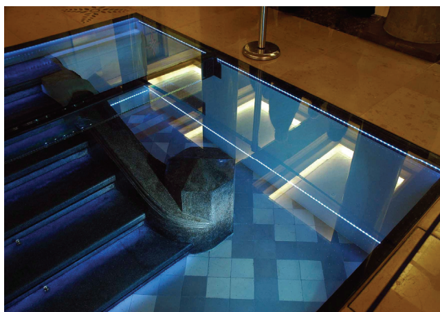
Rys. 6. Szklana posadzka na belkach szklanych – widok zabytkowych schodów
