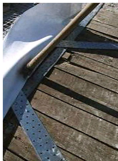
Fig. 18. Strengthening interventions, in-plane stiffening of existing wooden floors: metallic belts reinforcing wooden roof Rys. 18. Interwencje wzmacniające, usztywnienie istniejącego drewnianego stropu w płaszczyźnie: metalowe pasy wzmacniające drewniany strop
