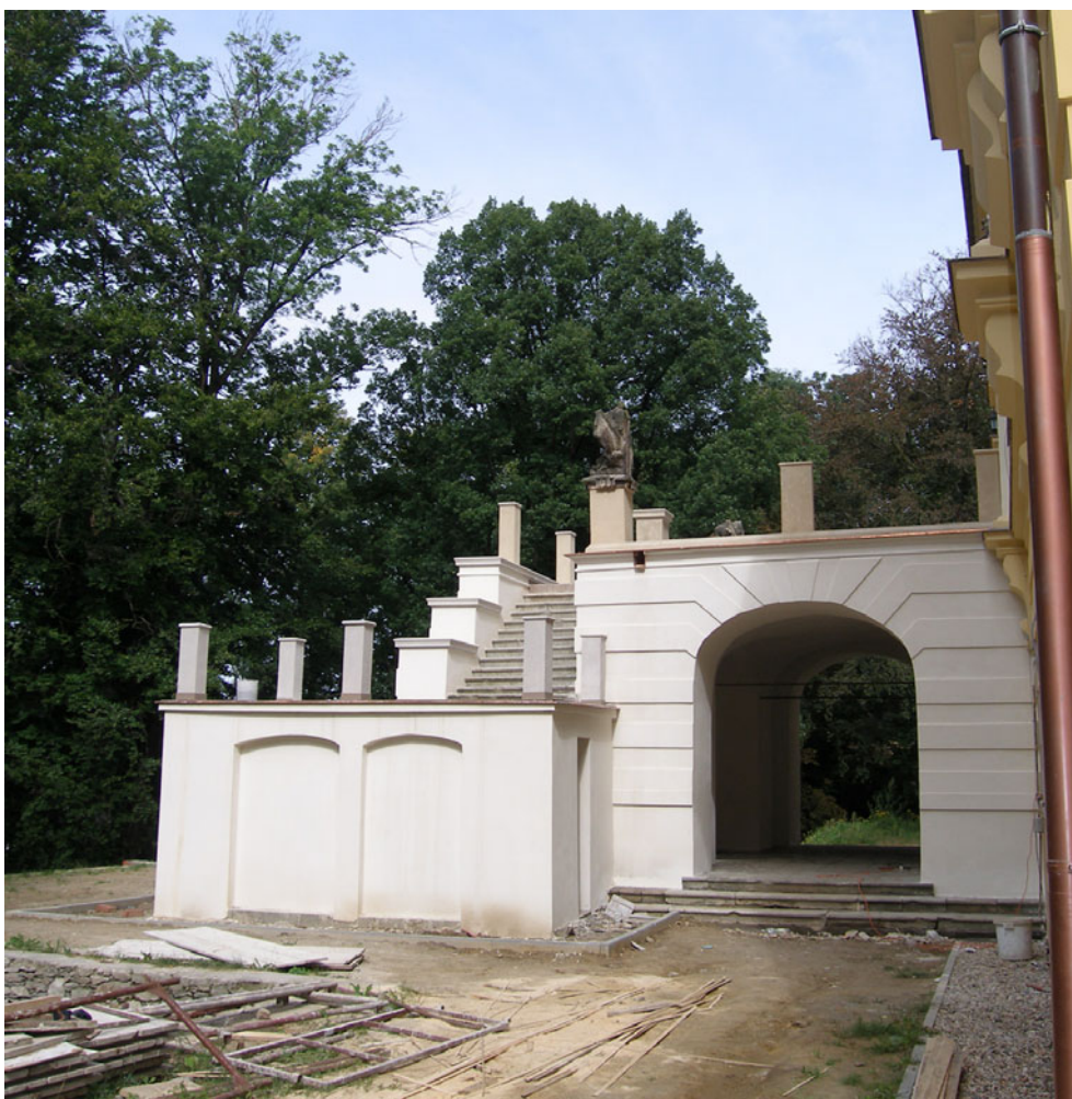
Rys. 12. Taras południowy – widok po renowacji Fig. 12. South terrace – view after renovation
