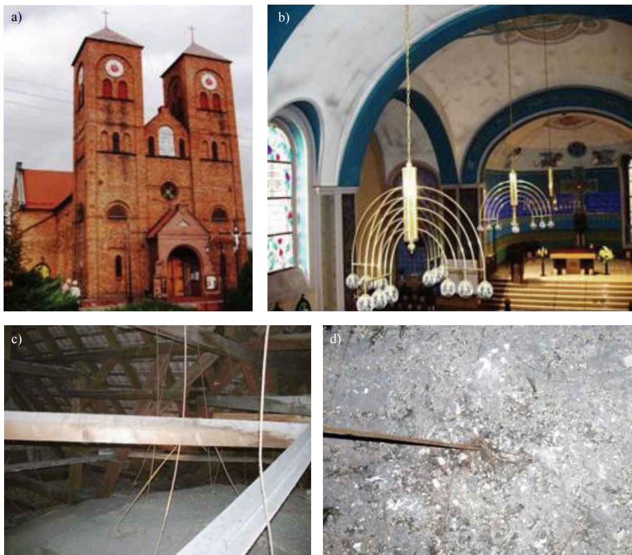
Rys. 13. Budynek kościoła: a) elewacja frontowa, b) wnętrze, c) sklepienie „Rabitz”, d) szczegół podwieszenia Fig. 13. Church building: a) frontage facade, b) inside view, c) Rabitz vault, d) detail of the suspension
