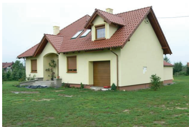
Rys. 7. Monitorowany nowy budynek Fig. 7. Monitored new building
