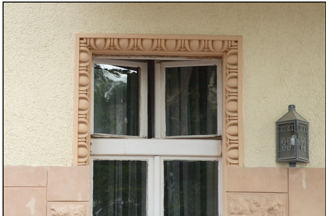
Rys. 11. Obrazienie okienne wykonane w cemencie romańskim (detal kamienicy przy ul. Józefińskiej w Krakowie) Fig. 11. Window framing made in Roman cement (detail from the apartment house in Józefińska Street in Cracow)
