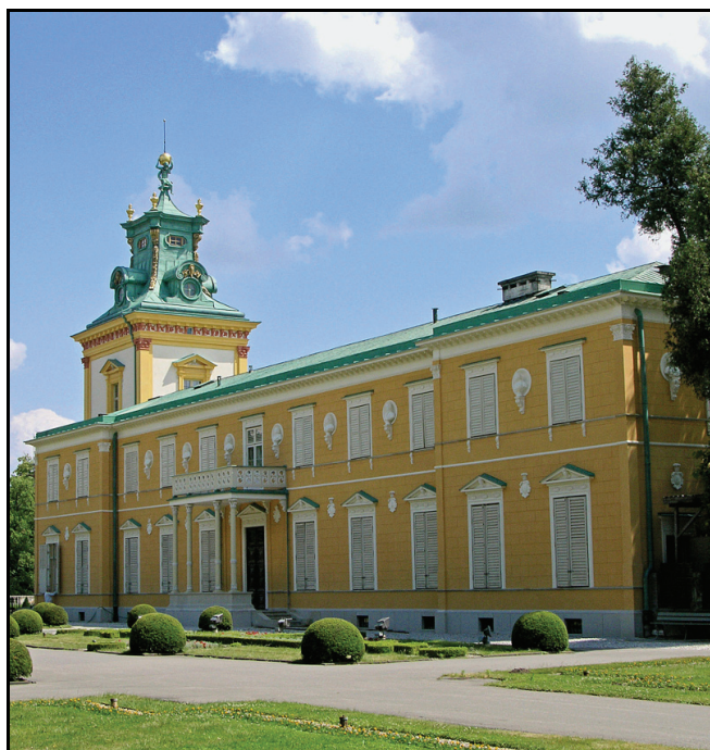
Rys. 10. Odrestaurowana elewacja północna skrzydła północnego
