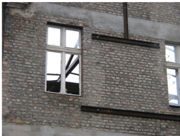
Rys. 10 Tymczasowe stężenia murów nośnych Fig. 10. Temporary bracing of structural walls
