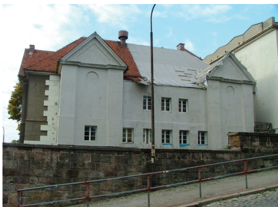
Rys. 1. Widok prawego skrzydła budynku szkoły Fig. 1. View of the right wing of the school building
