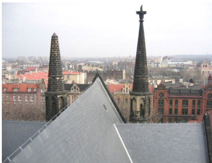
Rys. 3. Wymienione pokrycie dachu Fig. 3. The new roofing
