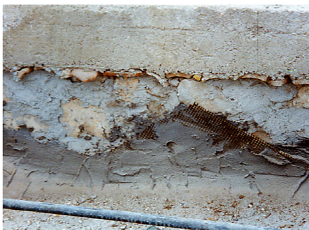
Preparation of vault's surface Przygotowanie powierzchni sklepienia
