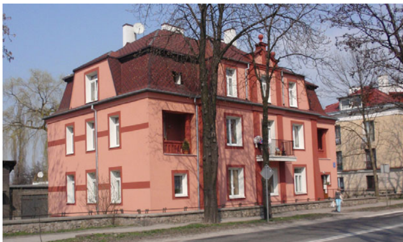
Rys. 6. Budynek kolonii kolejarzy w Lublinie po termorenowacji (fot. autor) Fig. 6. Railwaymen's colony building in Lublin after thermal insulation (photo by author)
