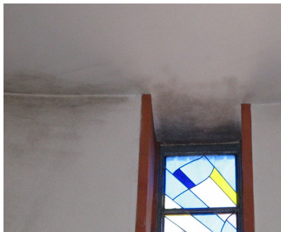
Rys.2. Ogniska zagrzybenia na kasetonowym stropie prezbiterium i stropie chóru Fig. 2. Places of mold growth on the ceiling surface in presbytery and choir
