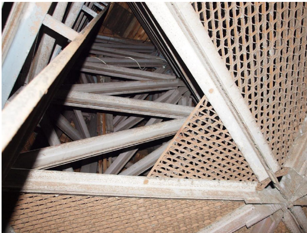
Rys. 8. Słup sercowy hełmu Fig. 8. Central pillar
