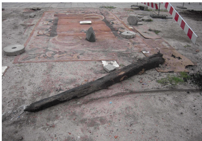
Rys. 7. Drewniany pal fundamentowy Fig. 7. Wooden foundation pile
