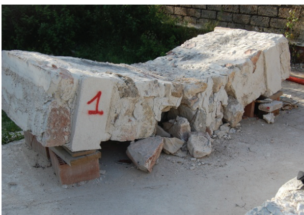
Fig. 8. Failure of panel 1 Rys. 8. Zniszczenie płyty 1
