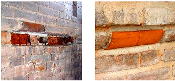
Fig. 6. Examples of "scuci-cuci" interventions on the bell tower of the Cathedral of Monza [4] Rys. 6. Przykłady interwencji typu „scuci-cuci” na dzwonnicy Katedry Monza [4]
