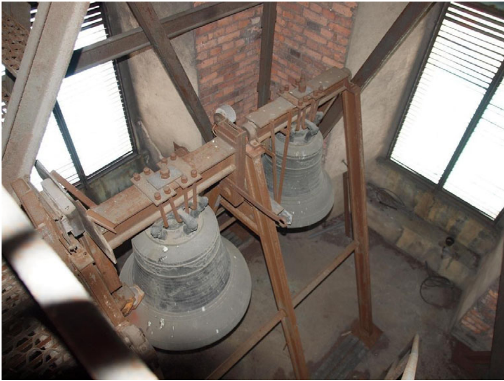
Rys.13. Zawieszenie dzwonów Fig. 13. Grapple of bells
