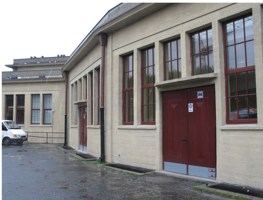
Rys. 5. Widok ściany Hali Stulecia po renowacji Fig. 5. The view of the wall of the Centennial Hall after renovation
