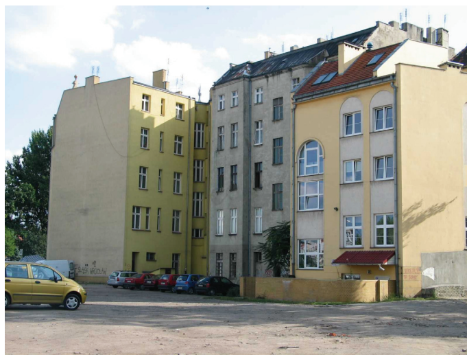
Rys. 5. Widok zespołu budynków od strony projektowanego wykopu Fig. 5. View of group of buildings from excavation site
