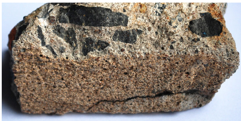
Rys. 4. Próbką betonu z elewacji z przed renowacji z widoczną warstwą ochronną Fig. 4. A sample of concrete taken from the façade before the renovation with the protective layer visible
