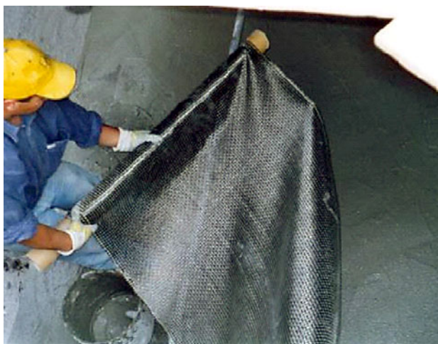
Application of Ruredil X Mesh C10 at vault's extrados Wprowadzenie Ruredil X Mesh C10 na grzbiecie sklepienia
