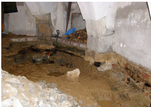
Rys. 13. Prace przy pogłębianiu krypty. W środku zdjęcia, u podstawy żebra widoczne szczątki szkieletów, które zostały pochowane pod posadzką krypty. Widoczna również woda gruntowa, zbierająca się w wykopach. Fot. A.J. Gaczoł, 2009 Fig. 13. The works aiming at deepening the crypt. In the centre: the remains of the skeletons, buried under the floor of the crypt, at the foundation of the rib and the ground water gathered in the ditch. Photo by A.J. Gaczoł, 2009
