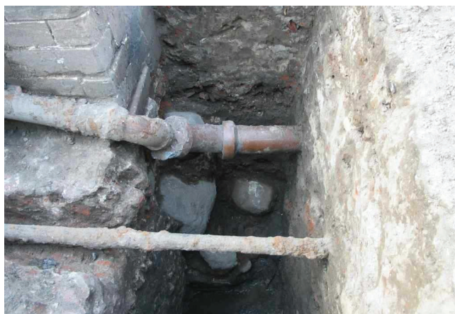
Rys. 12. Odkrywka fundamentu w narożu Fig. 12. View of foundation pit in corner
