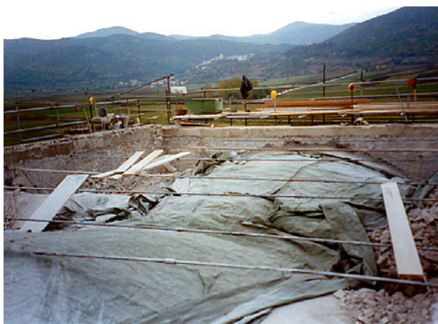
Preparation of vault's surface Przygotowanie powierzchni sklepienia
