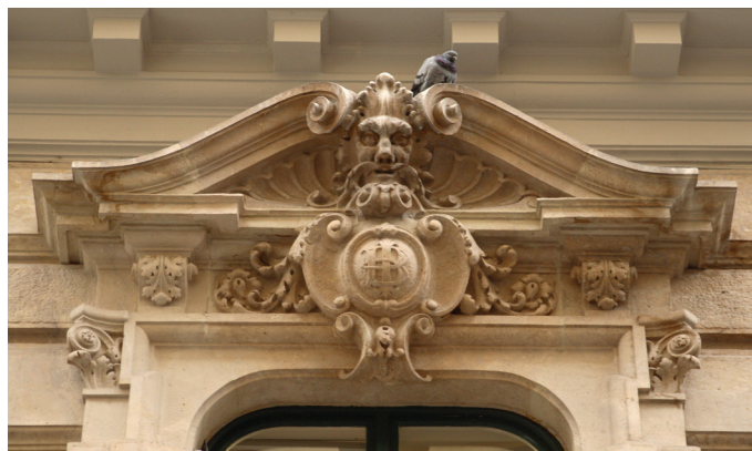
Rys. 3. Dekoracyjne obramienie okienne wiedeńskiej kamienicy, wykonane z cementu romańskiego
