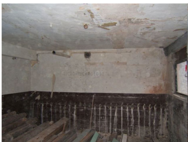
Rys. 14. Realizacja przepony poziomej Fig. 14. Making of horizontal insulating diaphragm
