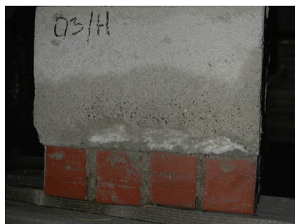
Rys. 2. Rezultat nałożenia tynku renowacyjnego w zbyt cienkiej, jednocentymetrowej warstwie
