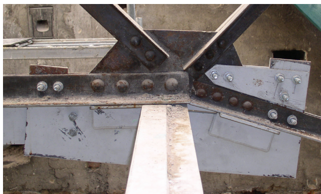
Rys. 6. Widok wzmocnionego węzła pasa dolnego wiązara trapezoidalnego Fig. 6. View of the strengthened node at the bottom chord in the trapezoidal truss
