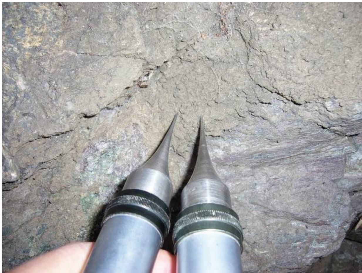
Rys. 8. Badanie zaprawy spoin metodą ultradźwiękową (fot. B. Stawiski) Fig. 8. Examination of mortar via ultrasound method (photo by B. Stawiski)
