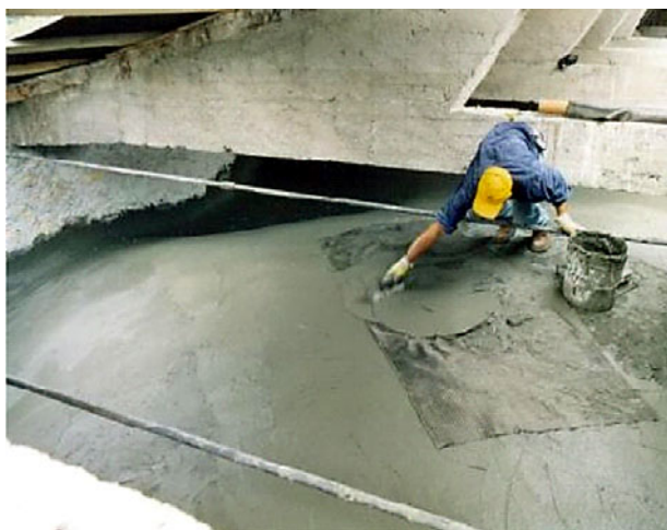
Application of Ruredil X Mesh C10 at vault's extrados Wprowadzenie Ruredil X Mesh C10 na grzbiecie sklepienia
