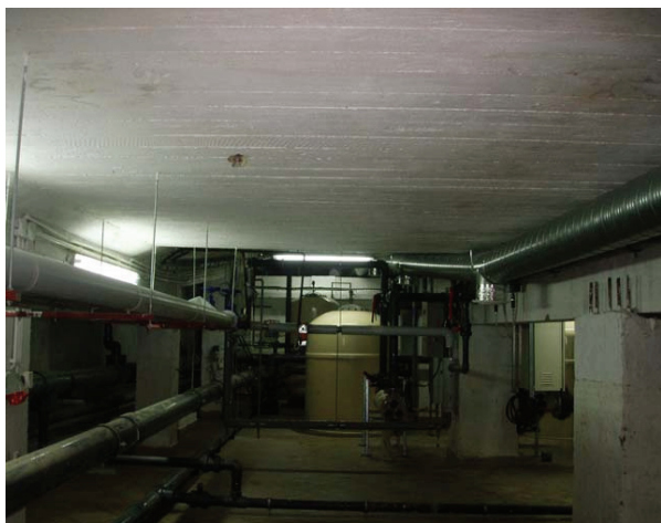
Rys. 2. Widok dna niecki basenu Fig. 2. View of pool basin bottom
