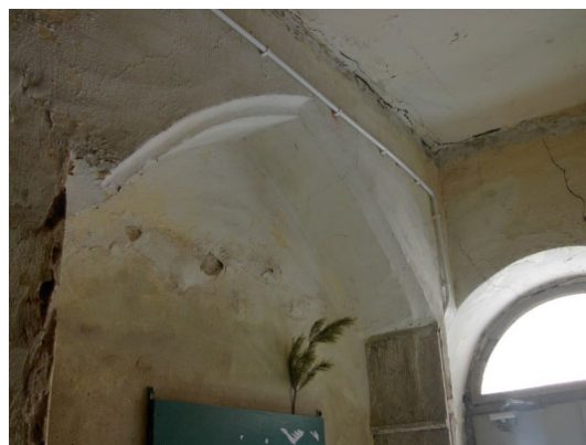
Rys. 3 Brzeg, ul. Reja 7, ostrołuczna, arkadowa wnęką na parterze kamienicy. Foto A. Peszko Fig. 3. Brzeg, 3 Rej St., ogival arcaded recess in the tenement house ground floor. Photo A. Peszko
