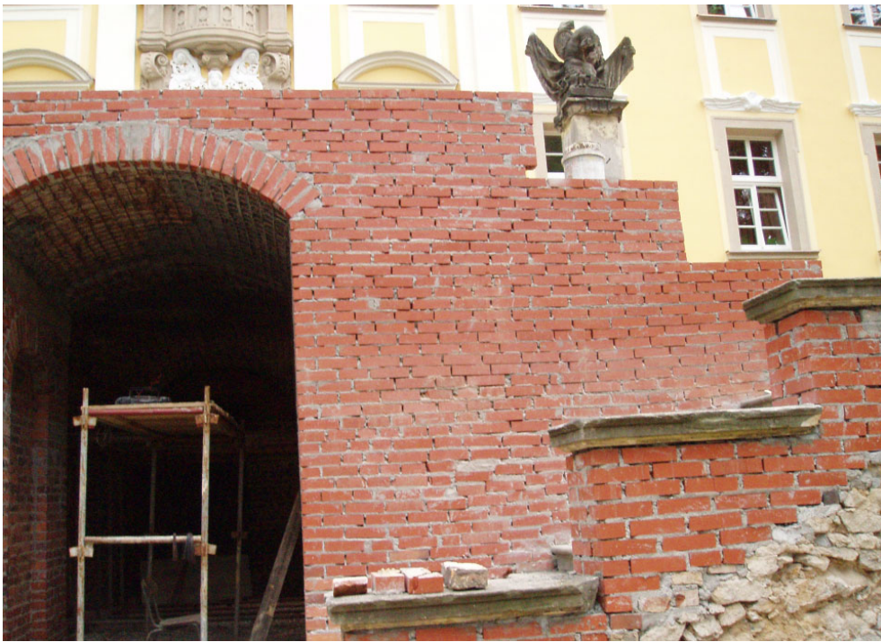
Rys. 9. Taras południowy – widok naprawy ścian tarasu oraz sklepienia Fig. 9. South terrace – view of the terrace walls and the vault being repaired
