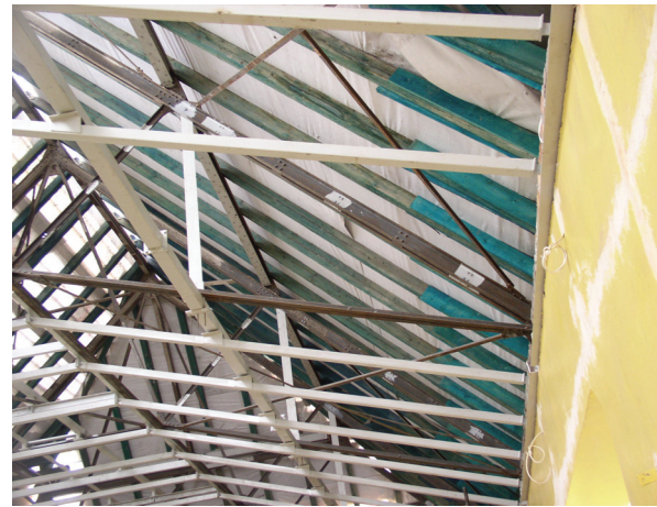
Rys. 8. Zbliżenie na konstrukcję nośną sufitu podwieszono (opis w tekście)
