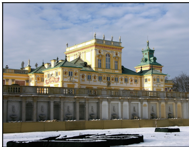
Rys. 6. Elewacja pałacu od ogrodu w nowej szacie kolorystycznej Fig. 6. The façade of the palace from the garden in the new color outfit
