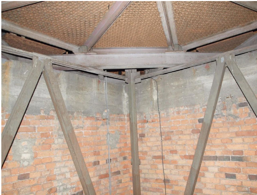
Rys. 7. Kotwienie podstawy hełmu Fig. 7. Anchoring base of the coupola
