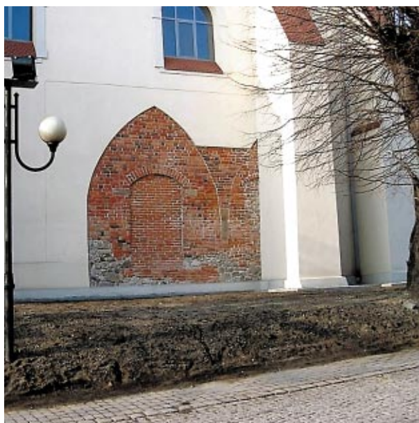
Ryc. 4. Wodzisław Śląski, kościół pofranciszkański, ściana południowa prezbiterium, przęsło zachodnie. Aranżacja konserwatorska ceglano lica wnętrza oratorium (wyk. GRUPA WĘĆŁAWOWICZ; fot. J. Węćławowicz, 2010)
