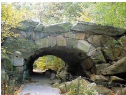
Ryc. 19. Huddleston Arch Fig. 19. Huddleston Arch
