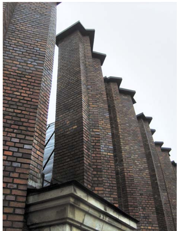
Ryc. 4. Widoczne odchylenia sterczyń po stronie zachodniej, fot. M. Łaba, październik 2011 Fig. 4. Visible deviations of pinnacles on the west side, photo: M. Łaba, October 2011
