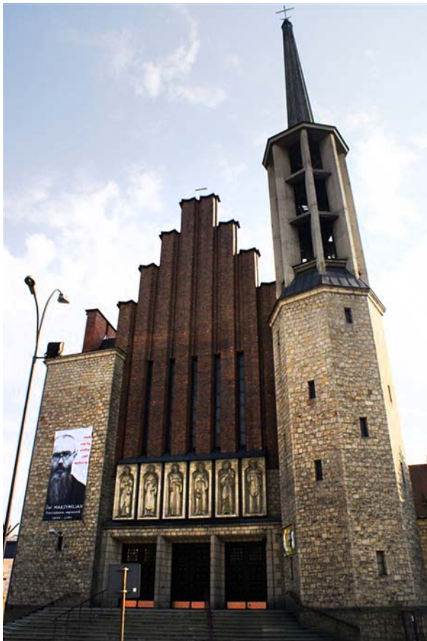
Ryc. 1. Fasada kościoła, fot. J. Figurska-Dudek, listopad 2012 Fig. 1. Facade of the church, photo: J. Figurska-Dudek, November 2012
