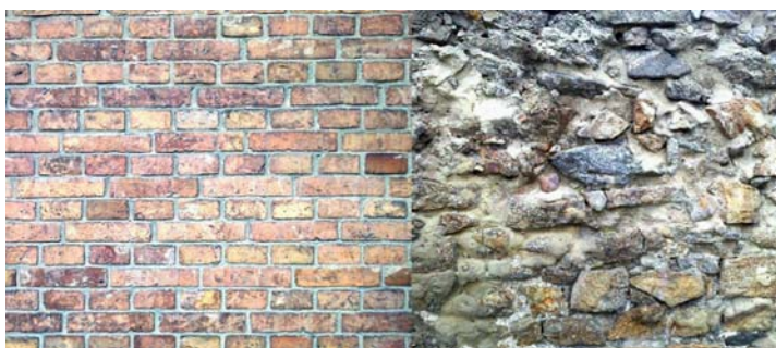
Ryc. 1. Przykładowe rodzaje historycznych konstrukcji murowych. Mur z cegły pełnej (po lewej) oraz mur kamienny (po prawej)
