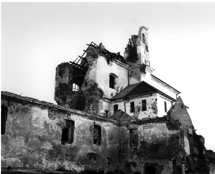
Ryc. 4. Budynek kościoła zniszczony podczas drugiej wojny światowej Fig. 4. The church destroyed during the Second World War
