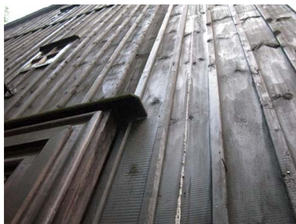
Ryc. 4. Nowe szalunki w kościele z XVII w. w Gąsawie. Widoczne ślady maszynowej obróbki desek szalunkowych
