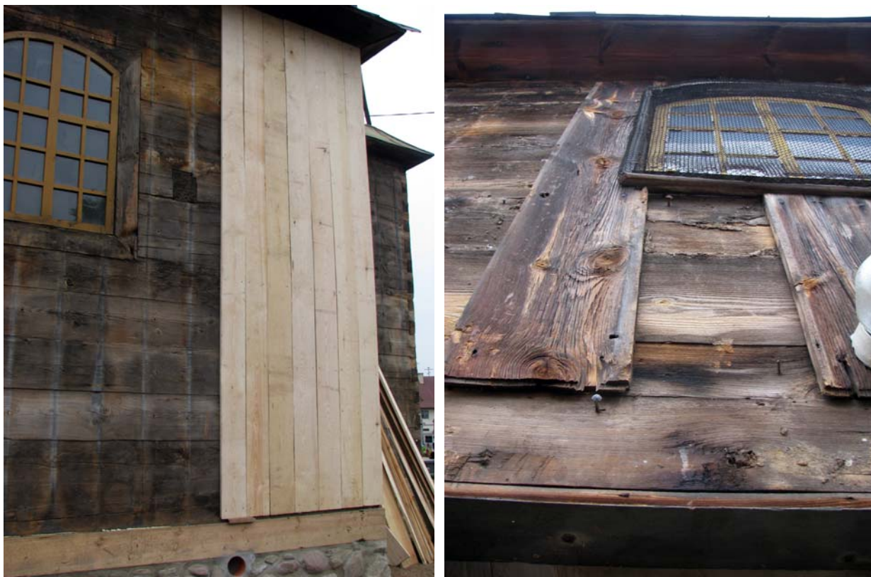
Ryc. 7 i 8. Nowe szalunki na ścianie kościoła pw. św. Anny z 1827 r. w Siemiatyczach. Widoczne ślady po szerokich deskach oryginalnych, resztki starych szalunków i oryginalne gwoździe kowalskie. Październik 2013 Fig. 7 and 8. New cladding on one of the walls of the St Anne's church (1827) in Siemiatycze. The traces left by the original wide planks are visible, the remains of old original cladding and original wrought-iron nails. October 2013
