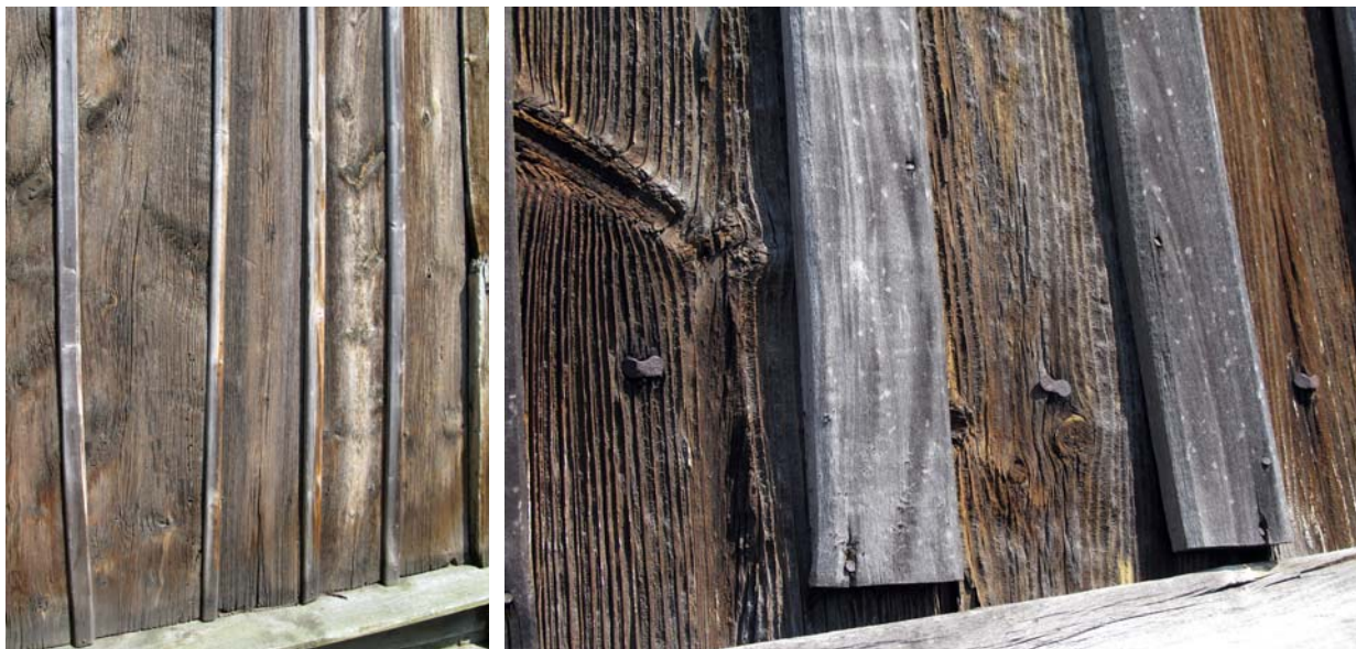
Ryc. 5 i 6. Stare szalunki w kościele z XVIII w. w Rembieszycach, woj. świętokrzyskie. Widoczny kształt desek i pierwsze gwoździe maszynowe z XIX w. Fig. 5 and 6. Old cladding on the 18 th century church in Rembieszyce, Świętokrzyskie Region. The shape of cladding boards and first machine-made nails (19 th century) are visible
