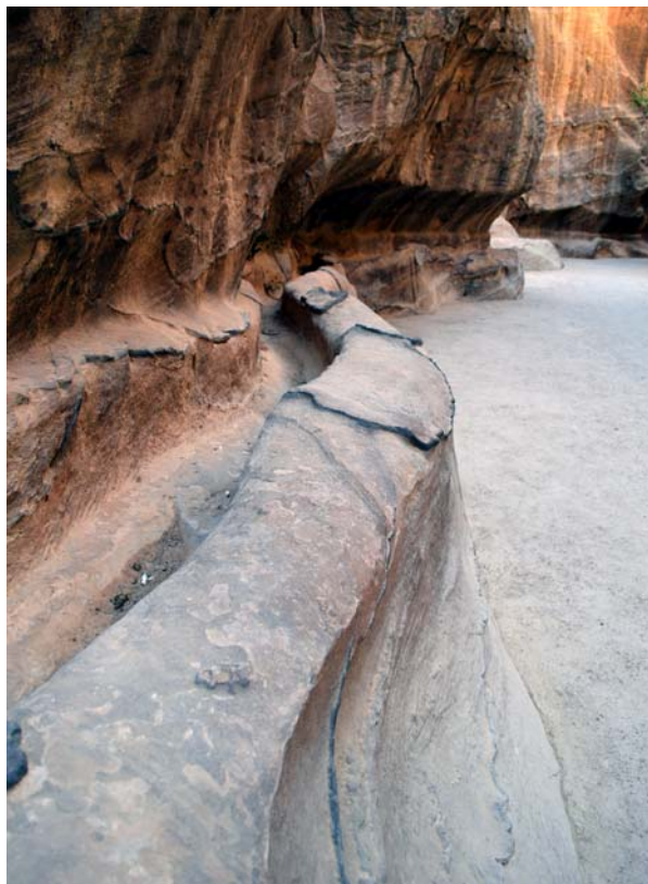
Ryc. 12a. Kanaly doprowadzające wodę do centrum Petry ze źródeł Ain Musa wykute w skałach po obu stronach Siq'u (Źródło Mojżesza, kilka kilometrów na wschód od Petry)
