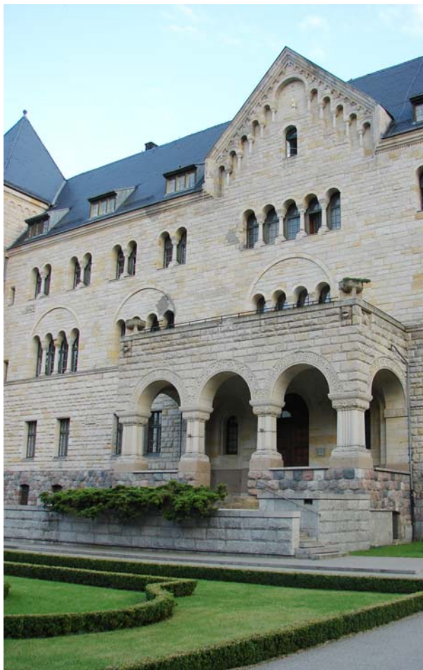
Ryc. 4. Poznań, Zamek Cesarski, dawne wejście główne. Stan obecny Fig. 4. Poznan, Imperial Castle, former main entrance. Current state
