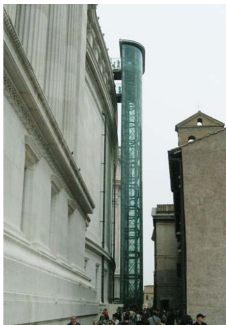
Ryc. 3. Zewnętrzny ażurowy szkielet windy, Complesso del Vittoriano, Rzym – fot. Ł. Wesółowski
