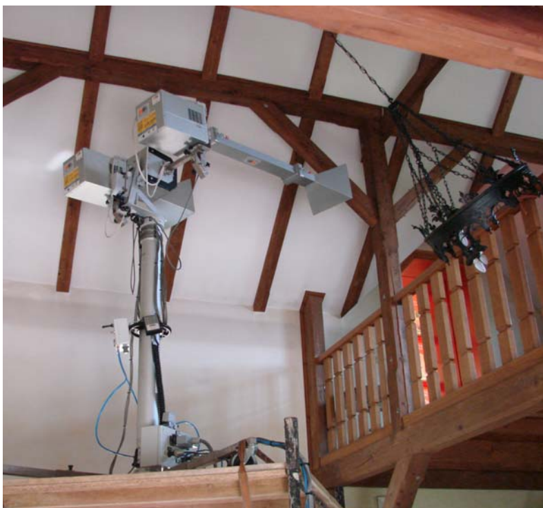
Ryc. 3. Zabieg mikrofalami w Biskupicach (materiały firmy Carsekt) Fig. 3. Microwave treatment in Biskupice (materials of the Carsekt Company)
