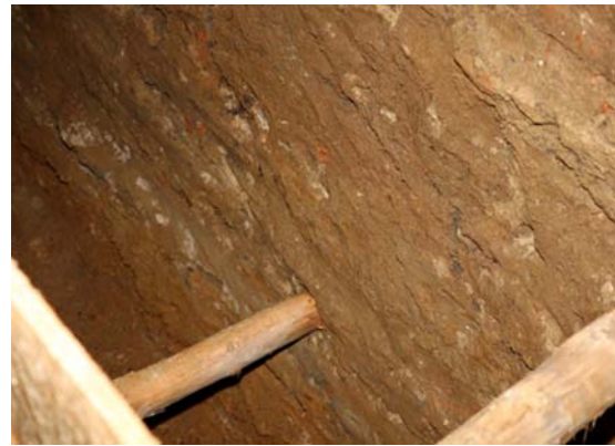
Ryc. 8. Sanktuarium w Starej Wsi – okrywka fundamentów – 2005 r. (fot. inż. J. Siwek) Fig. 8. The Sanctuary in Stara Wieś – foundation uncovered – 2005 (photo J. Siwek)
