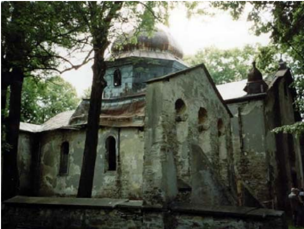
Ryc. 1. Cerkiew w Baligrodzie – stan przed remontem – 2005 r. (fot. Stowarzyszenie Ratowania Cerkwi w Baligrodzie) Fig. 1 The Orthodox Church in Baligród before restoration – 2005 (photo Save the Orthodox Church in Baligród Association)
