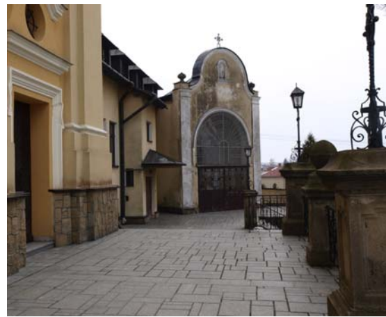
Ryc. 9. Sanktuarium w Starej Wsi – zestawienie stanu przed i po renowacji – marzec 2013 r. (fot. T. Huk) Fig. 9. The Sanctuary in Stara Wieś – before and after restoration – March 2013 (photo T. Huk)
