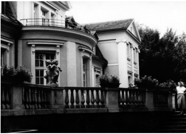
Ryc. 2. Pałac w Bieganowie, elewacja ogrodowa z tarasem, 1978. Źródło: zbiory prywatne prof. Z.J. Bialkiewicza Fig. 2. Palace in Bieganowo, garden elevation with terrace, 1978. Source: private archive of Z.J. Bialkiewicz
