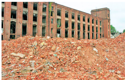
Ryc. 7. Fabryka Eiserta w trakcie prac rozbiórkowych (fot. F. Tomaszewski, 2005) Fig. 7. Eisert's Factory during demolition work (photo: F. Tomaszewski, 2005)
