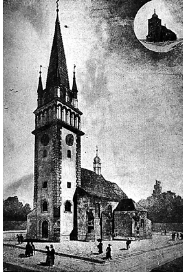
Ryc. 8. Kościół św. św. Szymona i Judy w Skawinie po przebudowie wg rysunku arch. W. Ekielskiego, [w:] „Architekt” 1902 r., R. 3, nr 11, s. 150
