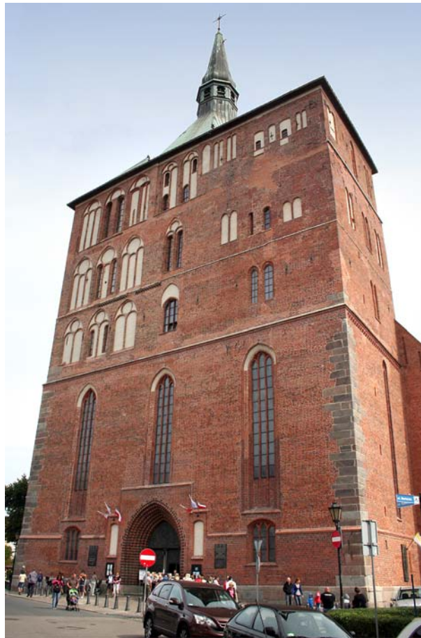
Ryc. 2. Widok bloku wieżowego bazyliki od strony południowo-zachodniej Fig. 2. The south-west view of the tower block of the Basilica
