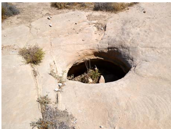
Ryc. 8-10. Hydrotechnika: tzw. zbieracze wody i wykute w skale cysterny na wodę
