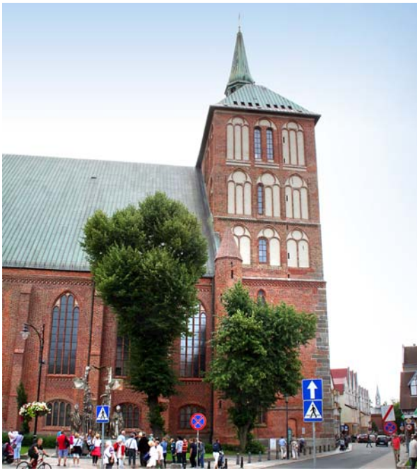
Ryc. 1. Fragment północnej elewacji bazyliki Fig. 1. Northern façade of the Basilica
