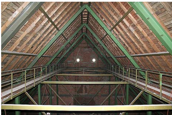
Ryc. 7. Odbudowana w latach 80. stalowo-drewniana konstrukcja dachu nad nawami
