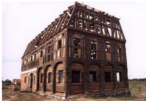
Ryc. 4. „Zagroda Kołodzieja” w Zgorzelcu – montaż konstrukcji w nowej lokalizacji – http://www.zagrodakolodzieja.pl/file.php?id=386&w=&h=& , dostęp 08.2016
