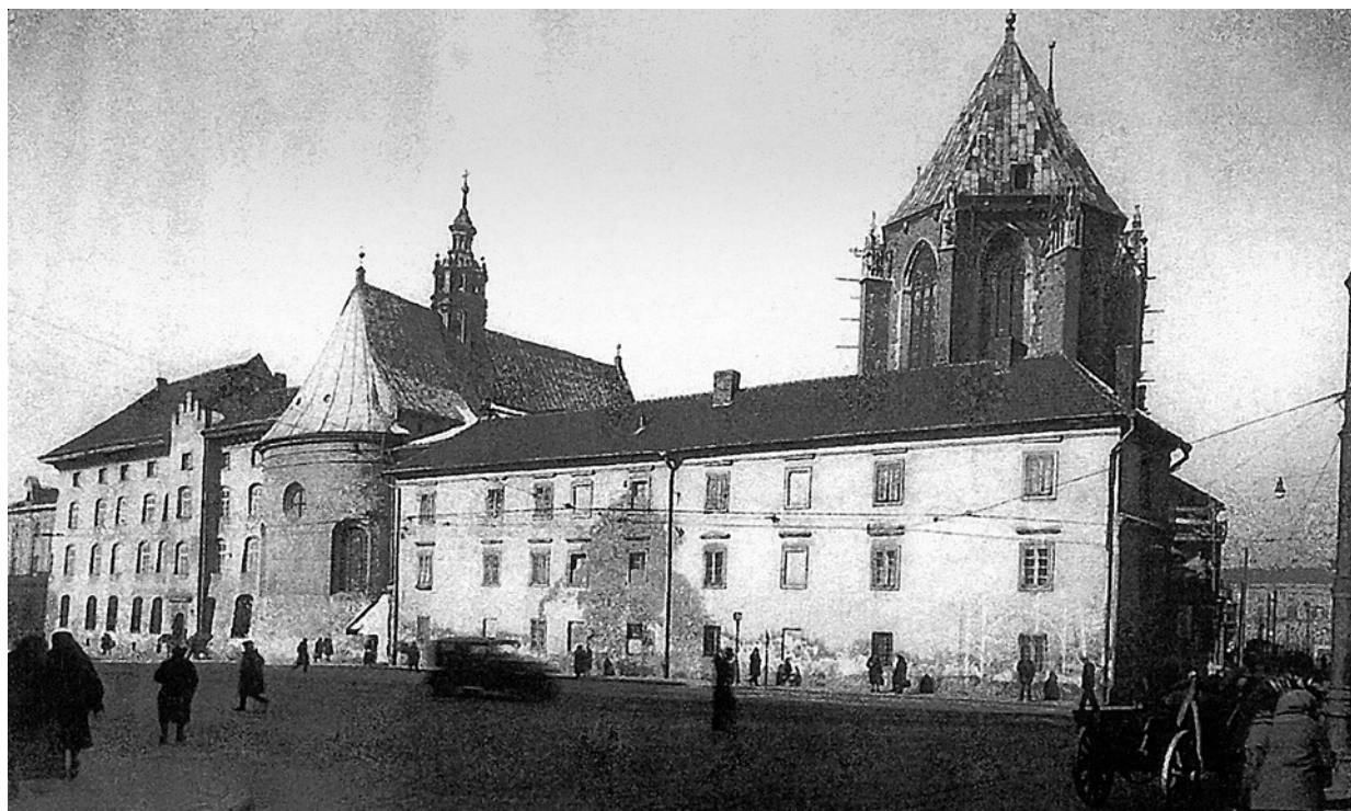
Ryc. 15. Kraków, Mały Rynek. Widok na budynek starej wikarówki z XVII/XVIII w. Stan przed rozbiórką w 1934 r. Fot. A.F. „Światowid” Reprod. ze zbiorów autora
