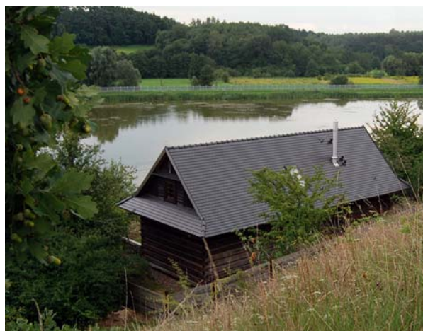
Ryc. 8. Dom jednorodzinny w podkrakowskich Balicach, widok od strony północno-wschodniej – Ł. Wesółowski, 2016
