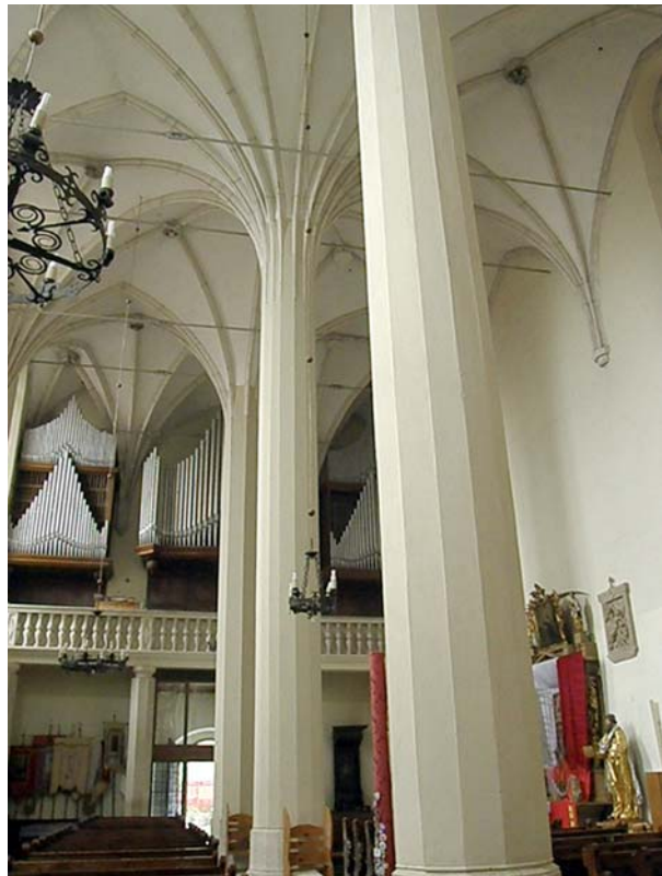
Ryc. 9. Wiślica. Wnętrze bazyliki kolegiackiej po odbudowie i obecnie. Fot. autor
