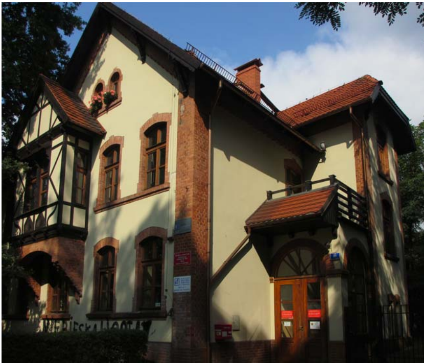
Ryc. 13. Budynek Miejskiej Biblioteki Publicznej filia nr 7 przy ul. Franciszkańskiej 25. Fot. autorka, 08.2016
