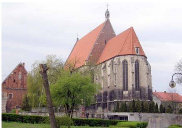
Ryc. 10. Wiślica. Bazylika kolegiacka z południowego wschodu. Widoczna sygnaturka na wschodnim szczycie nawy zaprojektowana przez A. Szyszko-Bohusza. Fot. autor
