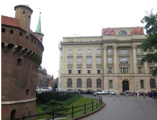
Realizacja – ul. Basztowa, Kraków
