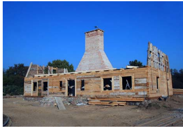
Ryc. 6. Odbudowa dworu szlacheckiego na terenie Muzeum Wsi Mazowieckiej w Sierpcu – http://mwmskansen.pl/wp-content/uploads/2011/12/11.-Budowa-dworu-na-terenie-skansenu.jpg , dostęp 08.2016
