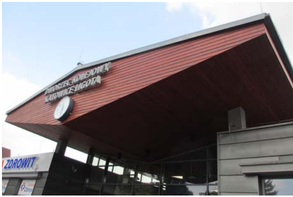
Ryc. 11. Dworzec kolejowy Katowice-Ligota po remoncie generalnym w 2016 roku. Fot. autorka, 08.2016
