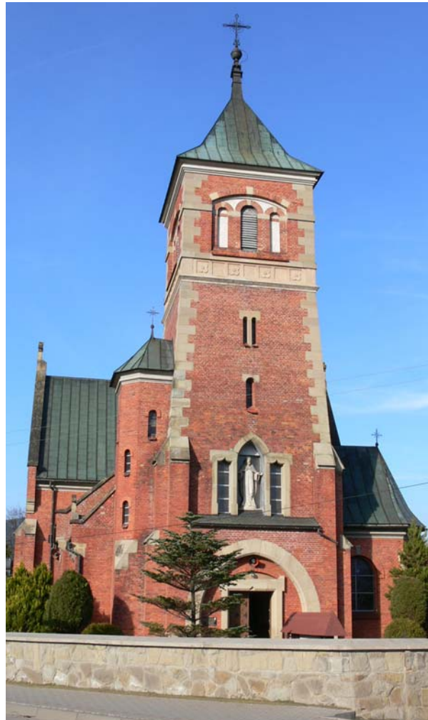
Ryc. 5. Widok od strony południowej – wieża kościoła – zdjęcie autora
