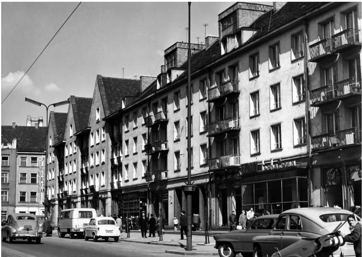
Ryc. 2. Wrocław, ul. Świdnicka 2–8b, budynek mieszkalno-usługowy, widok od strony południowo-zachodniej, fot. T. Olszewski, lata 60. XX w. Fig.2. Wrocław, 2–8b Świdnicka St., residential – service building, view from the south-west, photo: T. Olszewski, the 1960s
