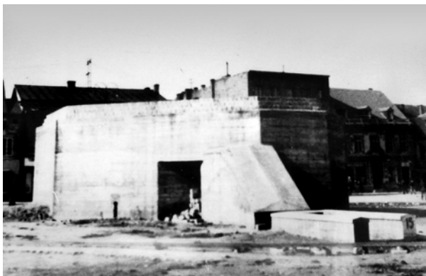
Ryc. 4. Oświęcim. Rynek Główny. Końcowy etap budowy niemieckiego bunkra z widocznym wejściem do podziemi. Fot. z 1943 r., autor nieznany. Materiały informacyjne Urzędu Miasta Oświęcim
