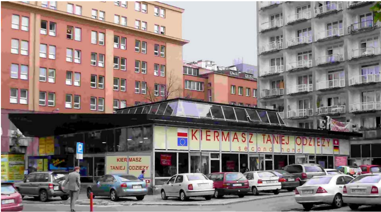
Ryc. 2. Warszawa, ul. Bracka 9, pawilon Chemii, proj. Jan Bogusławski, realizacja 1960–61, widok ogólny, stan w 2008 roku. Fot. J. Lewicki. Budynek o uznanych wartościach architektonicznych i eksperymentalnej konstrukcji oraz o charakterystycznej formie estetycznej rozebrany w 2008 roku mimo wpisania go na Listę Dóbr Kultury Współczesnej Oddziału Warszawskiego SARP
