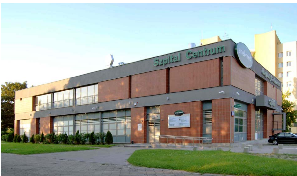
Ryc. 4. Warszawa, bar „Wenecja”, proj. Zbigniew Ihnatowicz, Jerzy Sołtan, Adolf Szczepański, realizacja X 1959–1 V 1961. A. Stan pierwotny; B. Stan obecny. Fot. J. Lewicki 2013. Przykład przekształcenia cennego budynku modernistycznego na skutek braku oceny jego wartości Fig. 4. Warsaw, the bar “Wenecja”, designed by: Zbigniew Ihnatowicz, Jerzy Sołtan, Adolf Szczepański, realised between 10.1959–1.05.1961. A. Original state; B. Current state. Photo: J. Lewicki 2013. Example of a valuable modernist building transformed as a result of lacking assessment of its value
