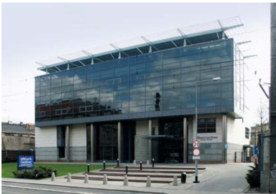
Ryc. 11. Bank przy ulicy Grzegorzeckiej Fig. 11. Bank building at the Grzegorzecka St.
