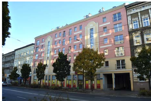
Ryc. 2. Nowy budynek, który zastąpił dawny pawilon handlowy „Barbara” z nominacją do „Makabryły Roku 2012”. Źródło: I. Kozłowska
