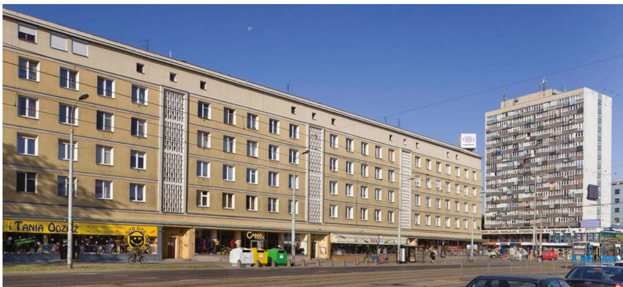
Ryc. 3. Wrocław, pl. Legionów 9–14, budynek mieszkalno-usługowy, widok od strony południowo-wschodniej, fot. S. Klimek Fig.3. Wrocław, 9–14 Legionów Sq., residential – service building, view from the south-east, photo: S. Klimek
