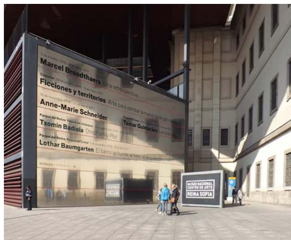
Ryc. 7. Muzeum Królowej Zofii – styk dwóch struktur (nowej i starej) w widoku od strony dworca i ruchliwych arterii miejskich – fot. K. Dudzic-Gyurkovich
