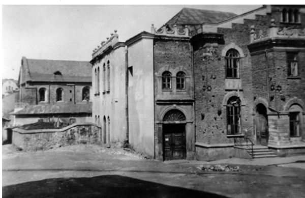
Ryc. 6. Fotografia z 1940 roku przedstawiająca synagogę Staromiejską (pierwszy plan) i Nowomiejską oraz mur otaczający cmentarz. Archiwum Państwowe w Rzeszowie
