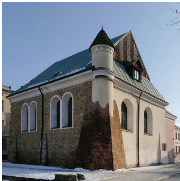
Ryc. 7. Fotografia przedstawiająca północno-zachodni narożnik synagogi Staromiejskiej, stan obecny. Fot. M. Główka
