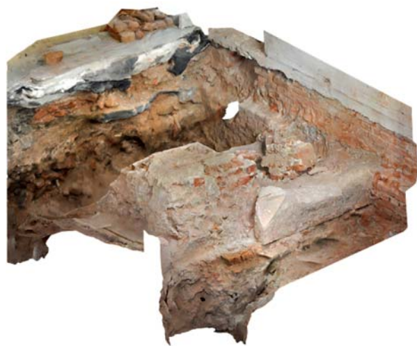
Ryc. 6. Widok na dwa zachowane ciosy oblicówki elewacji muru magistralnego pałacu oraz sekwencje relikto-wo, fot. Łukasz Łukaszewski
