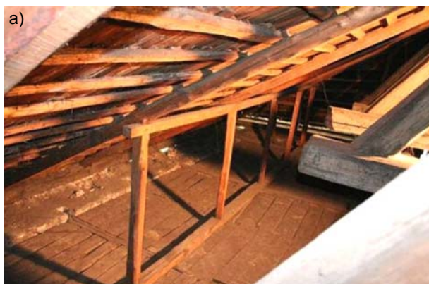
Ryc. 14. Kościół pw. św. Bartłomieja w Gliwicach: a) ugięcie krokwi i płatwi dawnej więźby, b) wymienione elementy Fig. 14. St. Bartholomew church in Gliwice: a) deflection of the old truss elements, b) elements after re-exchange
