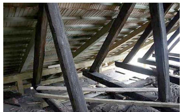
Ryc. 3. Namurnice i przypustnice oraz pokrycie dachu w trakcie remontu w kościele pw. św. Bartłomieja w Gliwicach
