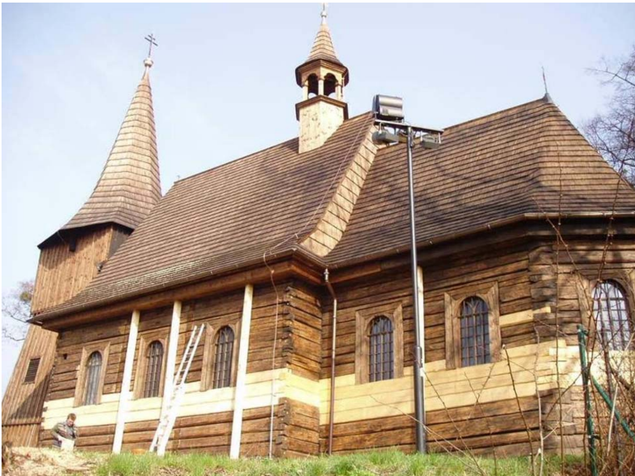
Ryc. 12. Wymiana elementów ścian i lisic w kościele pw. św. Michała Archanioła w Żernicy
