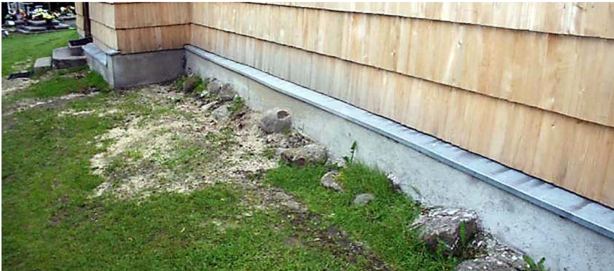
Ryc. 8. Otynkowane mury fundamentowe wraz z obróbką blacharską – rozwiązanie zgodne ze sztuką budowlaną, lecz sprzeczne z kanonami sztuki konserwatorskiej (kościół pw. Najświętszej Marii Panny w Szalszy z XVII w.)
