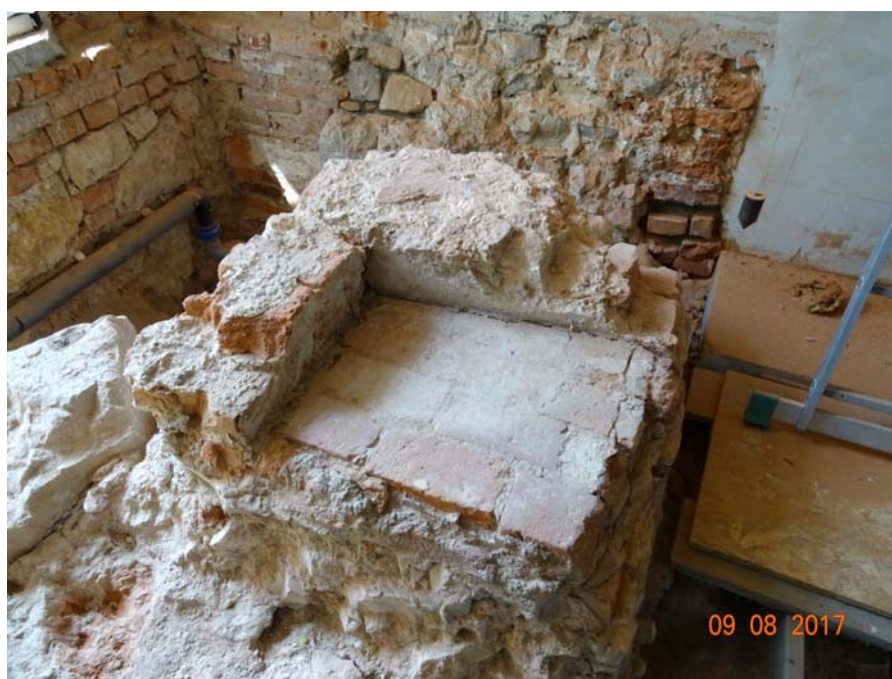
Ryc. 9. Ceglany poziom, być może fragment wnęki okiennej, fot. Klaudia Stala Fig.9. brick level, perhaps a fragment of a window niche, photo: Klaudia Stala
