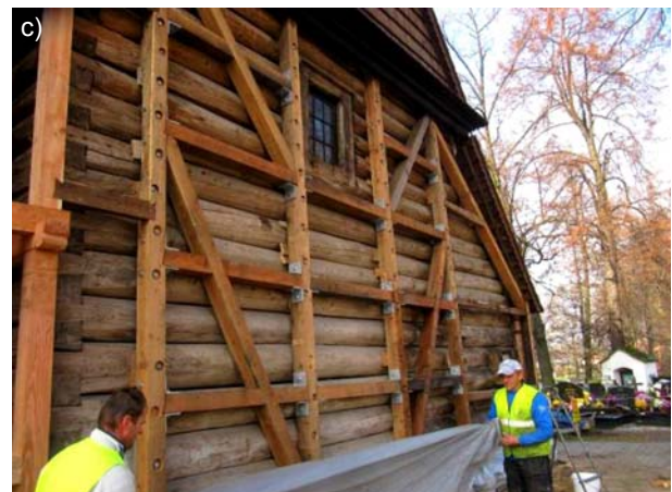
Ryc. 13. Wzmocnienie ścian: a) lisciami dwustronnie, b) lisciami jednostronnie, c) konstrukcją szkieletową
