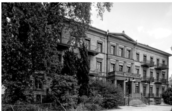
Ryc. 2. Główny budynek dawnego Landesirrenanstalt Heppenheim/ Bergstraße flankowany okazałymi dębami, fot. A. Staniewska
