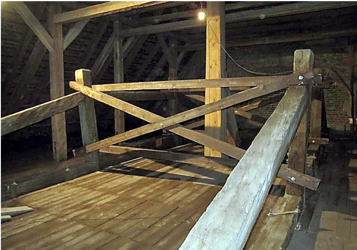
Ryc. 18. Wykonane stężenie wieszarów stropowych nawy kościoła pw. Podwyższenia Krzyża Świętego w Sławkowie Fig. 18. Strengthening of load-bearing trapezoidal girders in the Holy Cross church in Sławkow
