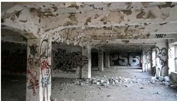
Ryc. 3. Fragment żelbetowej konstrukcji szkieletu budynku biurowego na poziomie II kondygnacji (fot. J. Dąbrowski)
