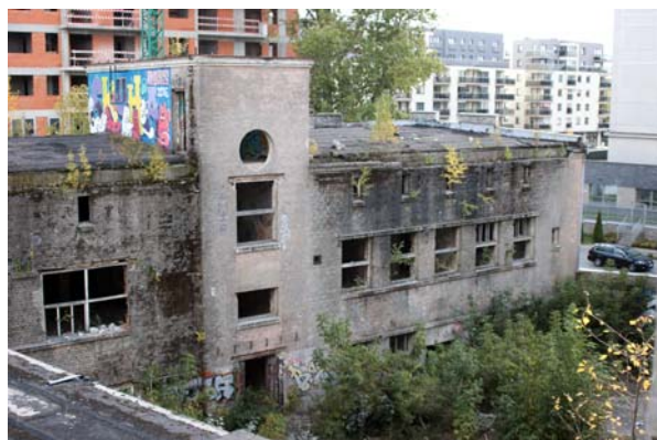
Ryc. 9. Elewacja frontowa budynku produkcyjnego, segment południowy – stan obecny (fot. J. Dąbrowski)
