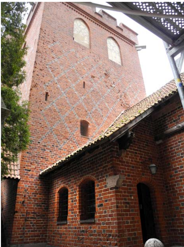
Ryc. 17. Wieża Klesza na Zamku Wysokim w Malborku. Elewacja południowa (fot. M. Prarat, 2015)
