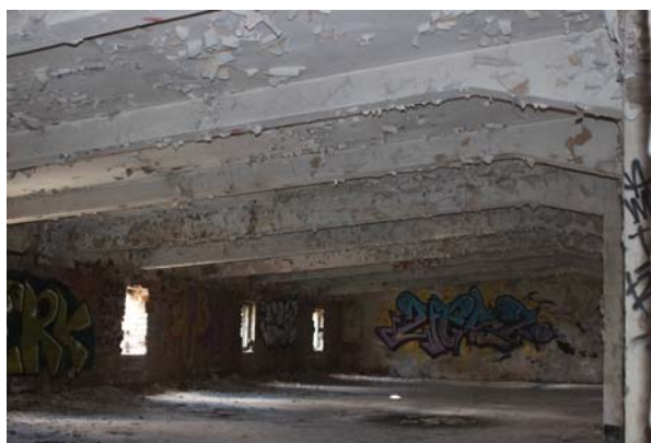
Ryc. 12. Konstrukcja poddasza z żelbetowymi krokiewiami (fot. J. Dąbrowski)
