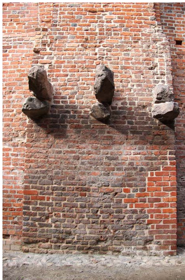
Ryc. 18. Wieża Klesza na Zamku Wysokim w Malborku. Elewacja wschodnia, filar północny z kamiennymi wspornikami (fot. M. Prarat, 2015)
