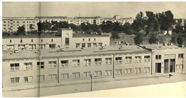
Ryc. 2. Elewacja frontowa budynku biurowego przy ul. Owsianej 14, widok z 1938 r. (za: 5 lat pracy Krajowych Zakładów Telefunken)
