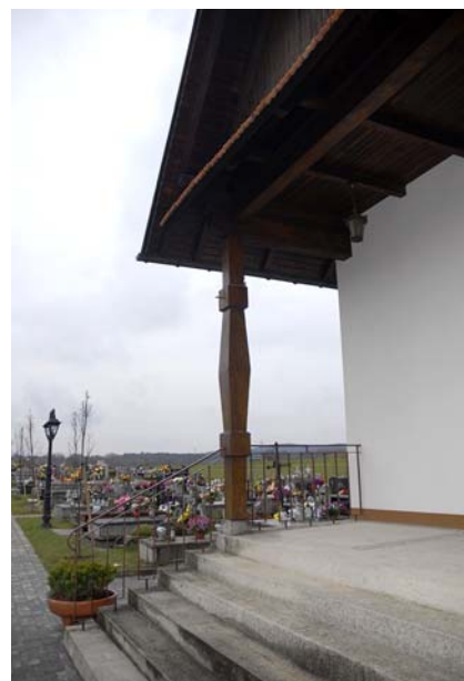
Ryc. 4. Kaplica cmentarna – przykład słupów o złych proporcjach Fig. 4. Cemetery chapel – example of columns with wrong proportions
