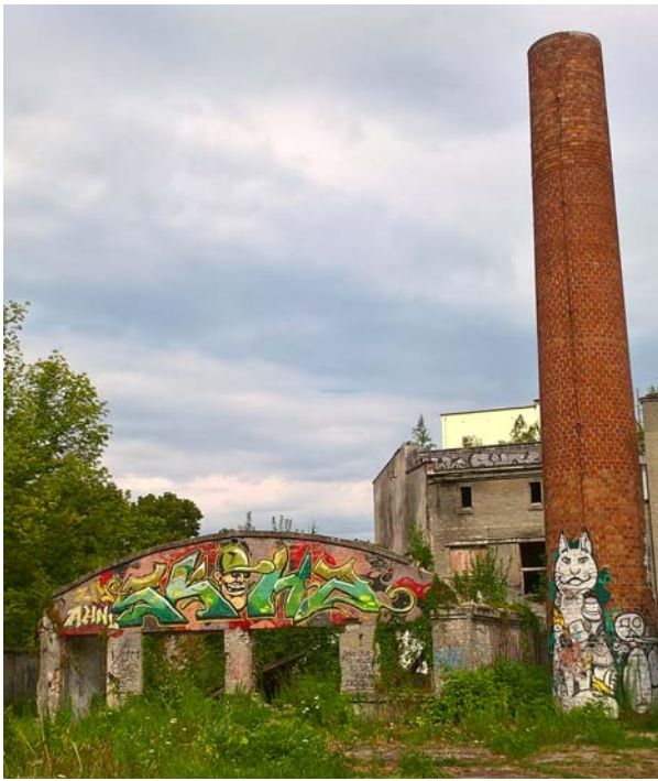
Ryc. 13. Widok kotłowni – stan obecny (fot. J. Dąbrowski)
