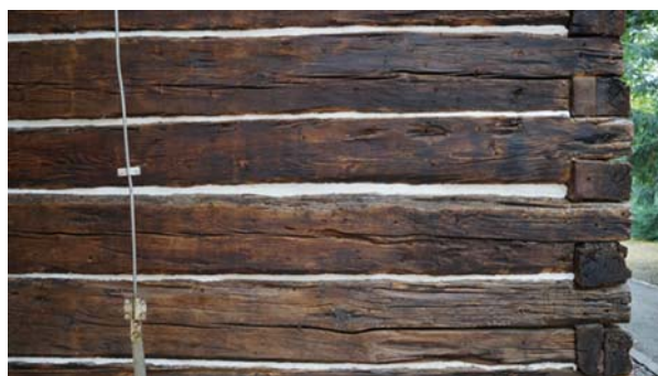
Ryc. 8. Wypełnienie spoin pomiędzy belkami ściany zewnętrznej kitem trwale plastycznym – przed renowacją (zdjęcie górne) oraz fugą mierzalną po remoncie (zdjęcie dolne)
