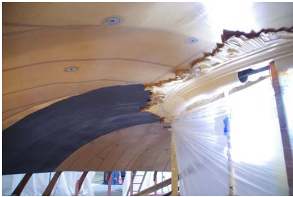
Ryc. 16. Wzmacnianie kopuły matami węglowymi od strony podniebienia (fot. Ł. Bednarz)
