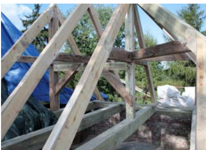
Rys. 33. Nowa więźba dachowa nad zakrystią z zachowaniem pierwotnych elementów
