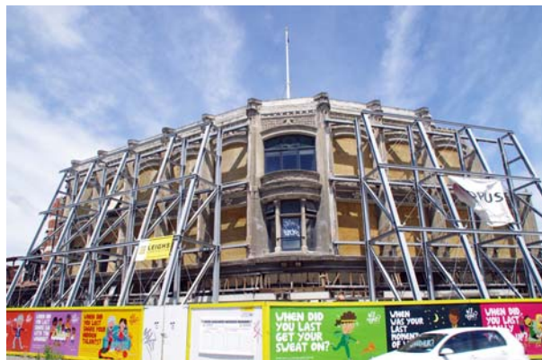
Ryc. 7. Jeden z budynków mieszkalnych ze wzmocnioną elewacją frontową, 2013 r. (fot. Ł. Bednarz) Fig. 7. One of the residential buildings with a reinforced front façade, 2013 (photo: Ł. Bednarz)
