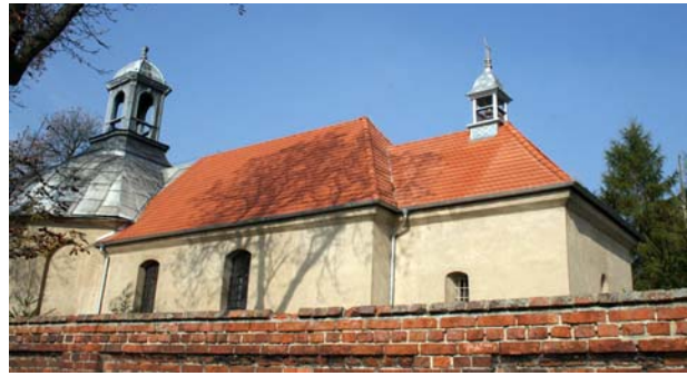
Rys. 39. Nowe dachy nad zakrystią i prezbiterium pokryte dachówką karpówką
