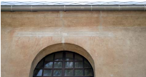
Rys. 49. Uzupelniony tynk na wzmocnio- nym łuku nadokien- nym
