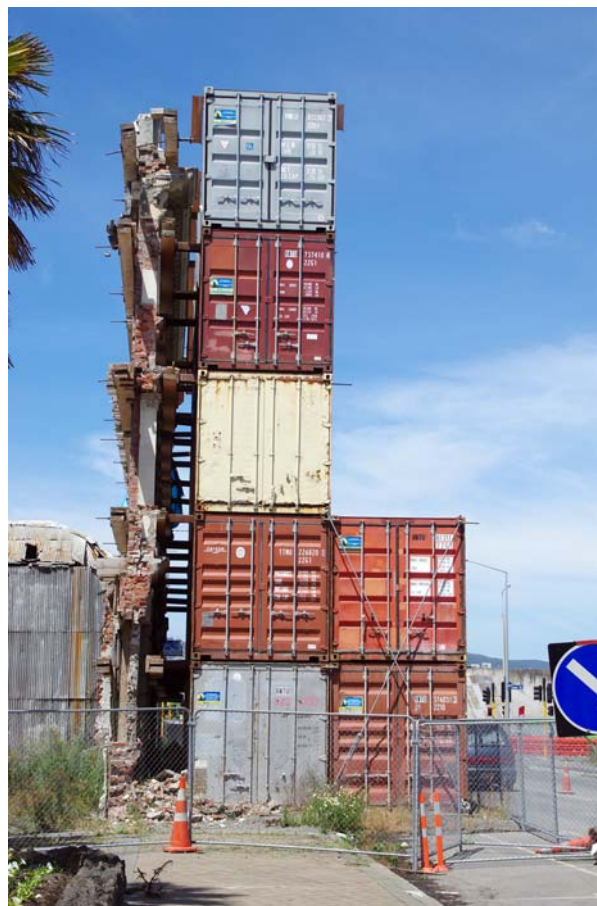
Ryc. 8. Wzmocniona kontenerami elewacja frontowa jednego z wyburzonych budynków mieszkalnych, 2013 r. (fot. Ł. Bednarz)
