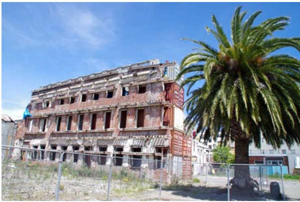
Ryc. 9. Wzmocniona kontenerami elewacja frontowa jednego z wyburzonych budynków mieszkalnych, 2013 r. (fot. Ł. Bednarz)
