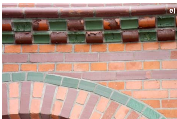
Ryc. 6. a) Projekt elewacji obiektu z XIX w. [19], b) współczesny wygląd budynku, c) fragment elewacji ceramicznej, d)–f) przykłady uszkodzeń elewacji obiektu
