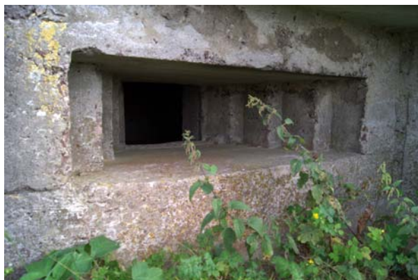
Fot. 5. Otwór strzelniczy w tradytorze jednostronnym usytuowanym w Strońsku Photo 5. Embrasure in a one-sided casemate located in Strońsk
