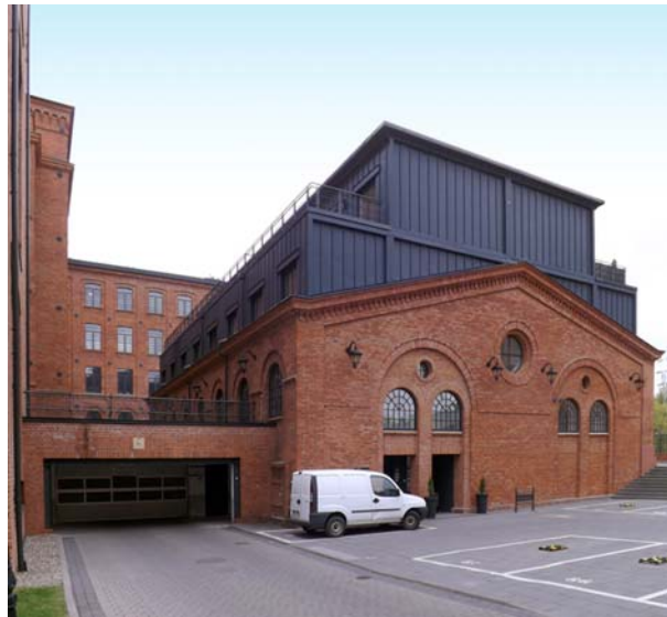
Ryc. 22. Łódź, Księży Młyn, rozbudowany obiekt pofabryczny – detal elewacji – fot. M. Gyurkovich
