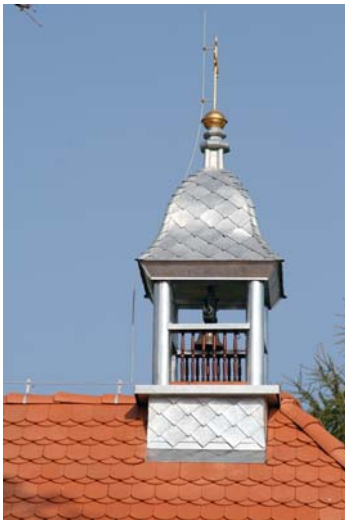
Rys. 40. Nowa sygnaturka z dzwonem nad zakrystią
