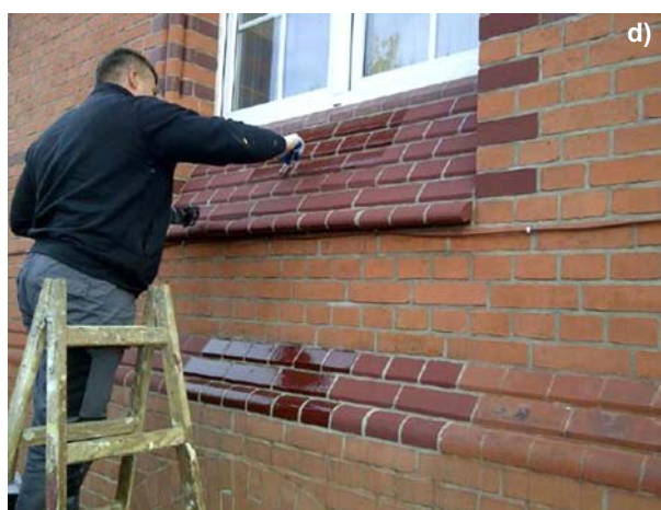
Ryc. 10. a) Czyszczenie fragmentu elewacji metodą piaskowania z drobną frakcją, b) nanoszenie warstwy gruntującej, c) nanoszenie powłoki malarskiej, d) nanoszenie powłoki poliuretanowej (fot. Wojciech Laska)
