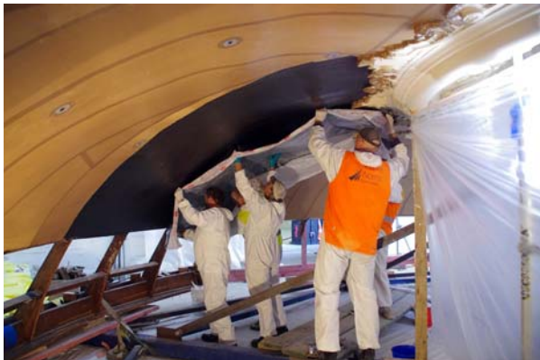
Ryc. 18. Wzmacnianie kopuły matami węglowymi od strony podniebienia (fot. Ł. Bednarz)
