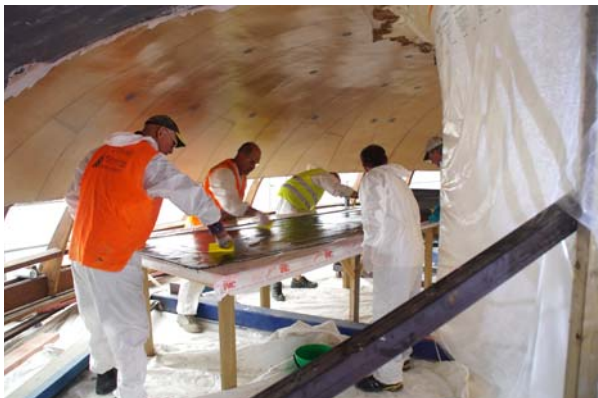
Ryc. 17. Wzmacnianie kopuły matami węglowymi od strony podniebienia (fot. Ł. Bednarz)
