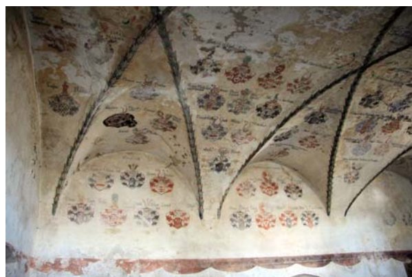
Ryc. 8b. Sistrzechowice, pałac, kaplica, fragment sklepienia po stronie południowej (fot. A. Legendziewicz)
