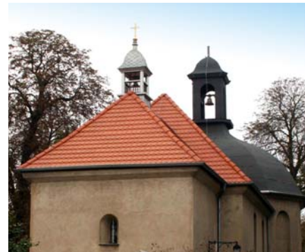
Rys. 45. Pseudokopuła i hełm pokryte termozgrzewalną papą podkładową
