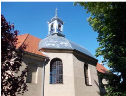
Rys. 46. Nowe pokrycie cynkowe pseudoko- pęły i helmu nad ośmioboczną nawą kościoła Fig. 46. New zinc-titanium covering of pseudo- dome and helmet over the octagonal nave
