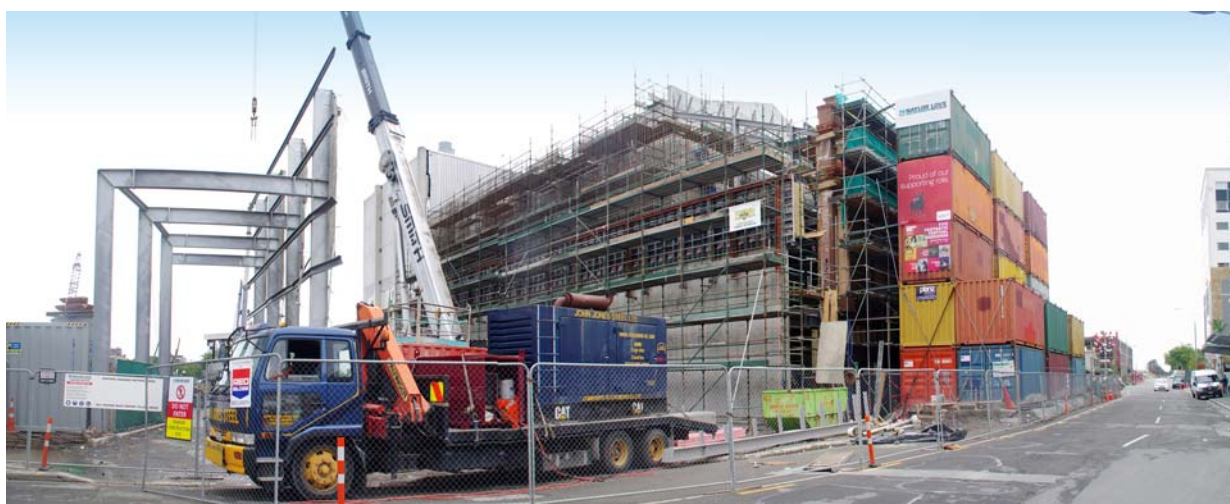
Ryc. 15. Połączenie historycznej elewacji z konstrukcją stalową i żelbetową, 2013 r. (fot. Ł. Bednarz)
