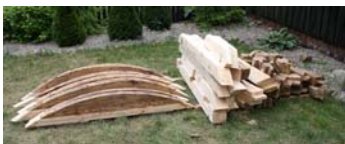
Rys. 41. Nowe i naprawione elementy konstrukcji pseudokopuły
