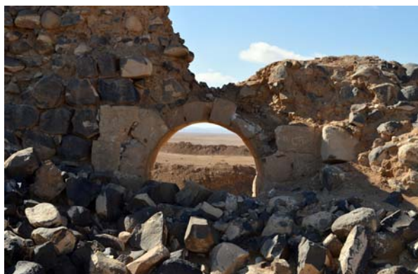
Ryc. 10. Dajaniya. Przejście w murze obronnym fortu (fot. K. Kopij)
