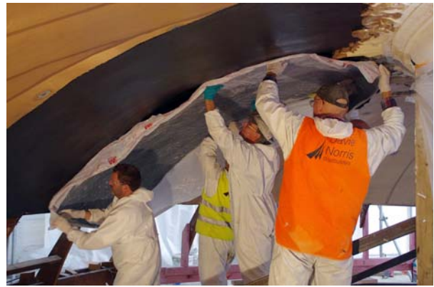
Ryc. 19 Wzmacnianie kopuły matami węglowymi od strony podniebienia (fot. Ł. Bednarz)
