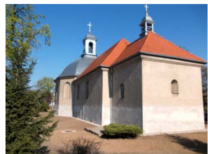
Rys. 52. Kościół pw. św. Idziego w Czerwonej Wsi. Widok obiektu i otaczającego terenu od strony południowo-wschodniej po zakończe- niu prac rewaloryzacyjnych
