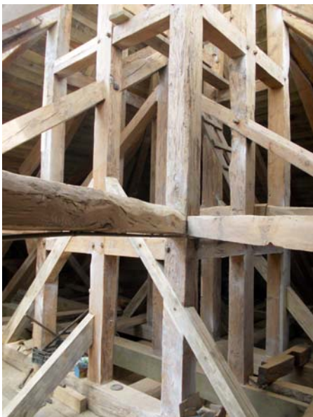
Rys. 10. Trzon słupowo-ryglowy pseudokopuły Fig. 10. Column-beam backbone of the pseudo-dome
