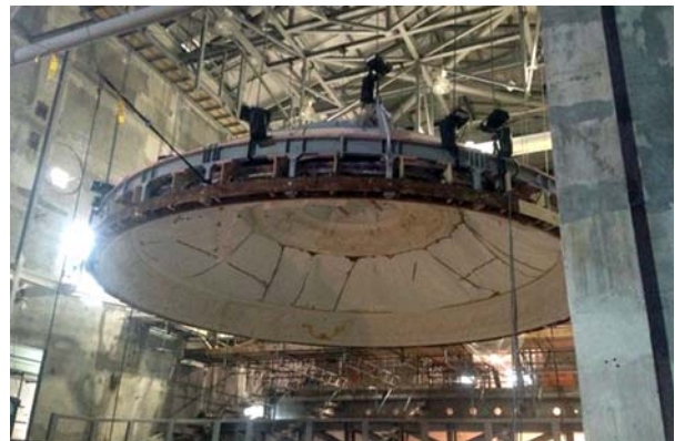
Ryc. 20. Montaż wzmocnionej i odrestaurowanej kopuły [14]
