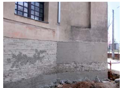
Rys. 51. Wykonywanie tynku renowacyjnego Fig. 51. Renovative plastering
