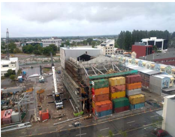
Ryc. 4. Isaac Theatre Royal podczas odbudowy, kolorowe kontenery zabezpieczają ulicę Gloucester przed ewentualnymi skutkami zawalenia się elewacji frontowej, 2013 r. (fot. Ł. Bednarz) Fig. 4. Isaac Theater Royal during reconstruction, colorful containers secure Gloucester Street against possible consequences of the collapse of the front façade, 2013 (photo: Ł. Bednarz)
