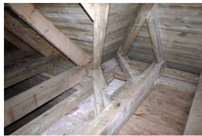
Rys. 34. Odtworzenie krokwi koszowej i narożnej oraz belek stropowych na styku zakrystii i prezbiterium
