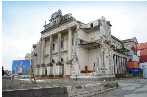
Ryc. 6. Ruiny bazyliki katolickiej, 2013 r. (fot. Ł. Bednarz) Fig. 6. Ruins of the Catholic Basilica, 2013 (photo: Ł. Bednarz)
