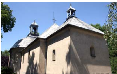
Rys. 2. Kościół pw. św. Idziego w Czerwonej Wsi. Widok od strony południowo-wschodniej przed wykonaniem prac remontowych
