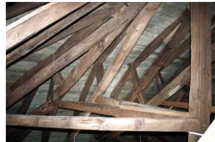
Rys. 44. Fragment naprawionej konstrukcji pseudokopuły
