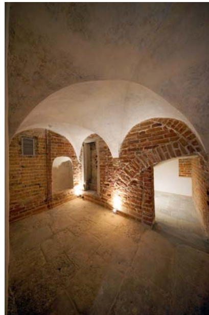
Ryc. 13. Pomieszczenie pod wieżą po pracach konserwatorskich. Fot. D. Kula, 2017
