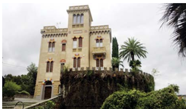
Ryc. 10–11. Adaptacje wież obronnych na mieszkalne, autor Paulina Łyziak-Dyga, 2017 Fig. 10–11. Adaptation of defensive towers to residential, author Paulina Łyziak-Dyga, 2017
