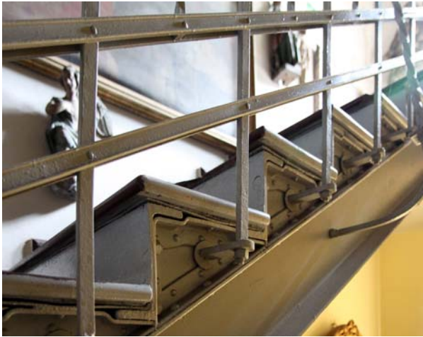
Ryc. 9. Schody południowe w budynku Muzeum Archidiecezjalnego przy ul. Kanonii 12–14 we Wrocławiu. Schody policzkowe o stopniach nasadzanych, wykonane ze znormalizowanych żelaznych kształtowników – ceowników i zetowników, blachy oraz stopnic ze skałodrzewu. Fot. A. Gryglewska, 2018
