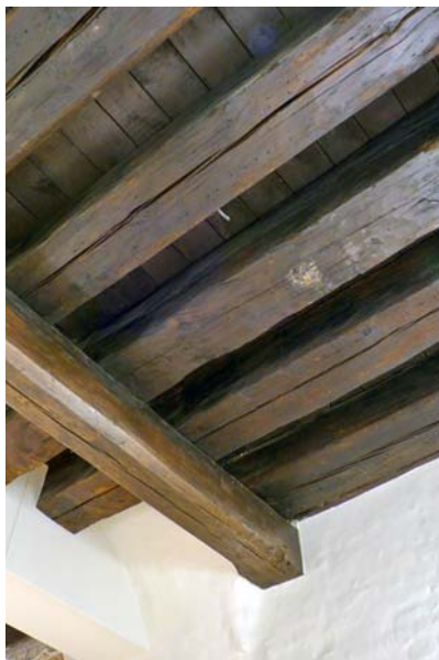
Ryc. 5. Odslonięty spod współczesnego sufitu strop belkowy z końca XIV w. Stan po pracach konserwatorskich. Fot. K. Darecka, D. Kula, 2016
