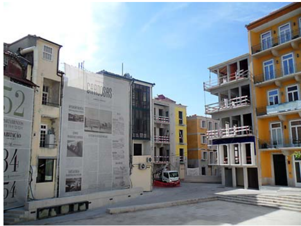
Ryc. 10. Widok na wnętrze kwartału Das Cardosas od strony północno-wschodniej, fot. autorzy
