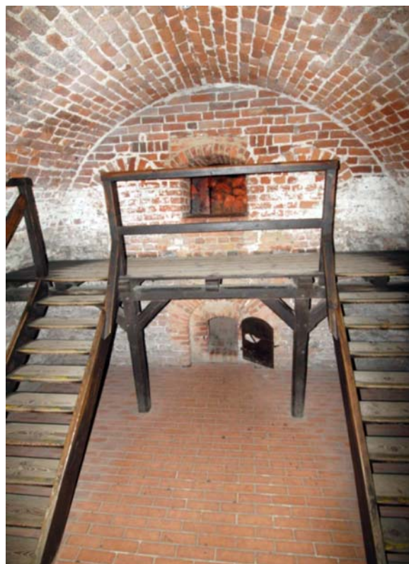
Ryc. 4. Zasada działania dwukomorowego pieca średniowiecznego oraz widok ściany czołowej pieca pod Wielkim Refektarzem na zamku w Malborku, źródło: B. Pospieszna, Wielki Refektarz na Zamku Średnim w Malborku. Dzieje, wystrój, konserwacja ; rys. J. Kacperska, fot. 7, s. 87; fot. A. Bojęś-Białasik
