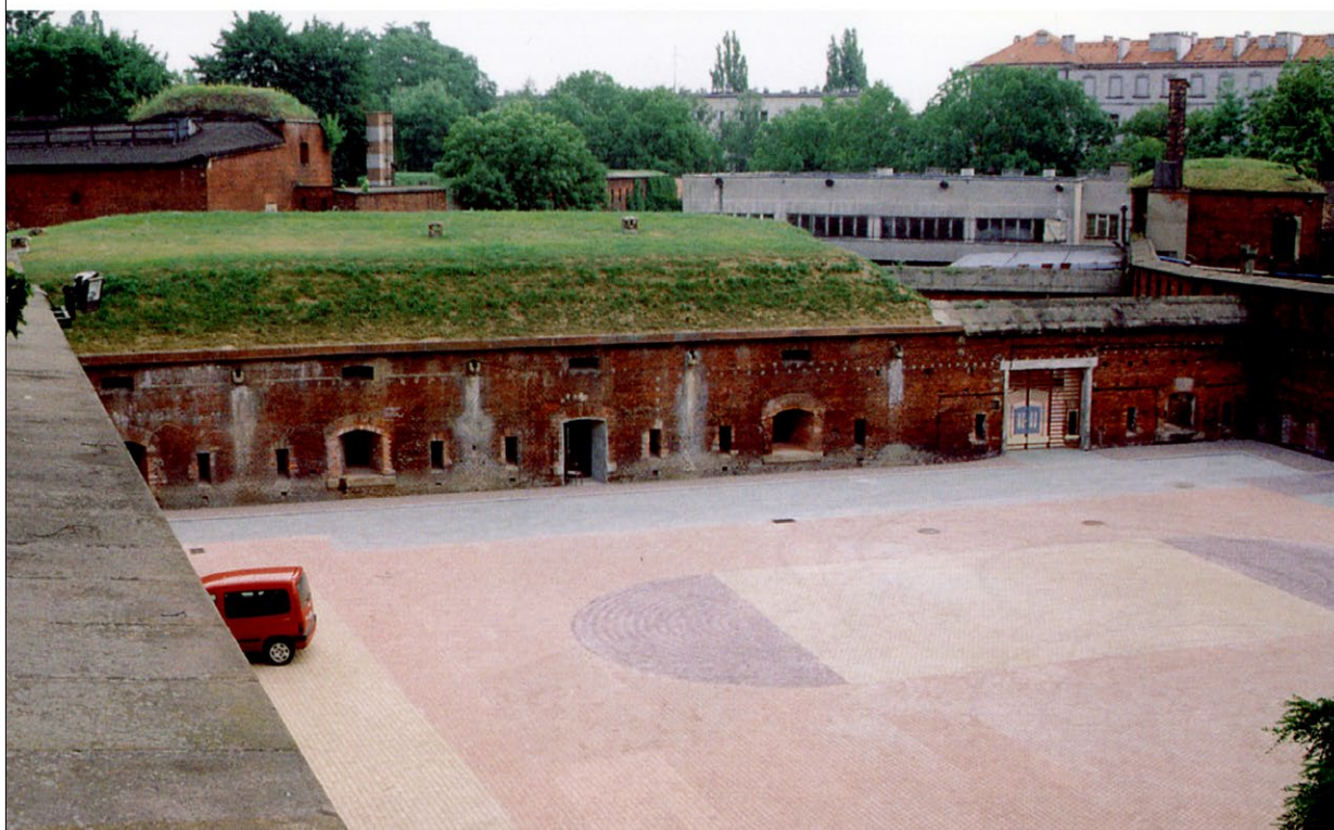
Ryc. 3. Plac wielofunkcyjny oraz kaponiera szyjowa Bastionu III „Kleparz” adaptowana na klub muzyczny; izolacja budynku wykonana bez zdejmowania nasypów na kazamatach w latach 2004–2006; fot. i rys. K. Wielgus.
