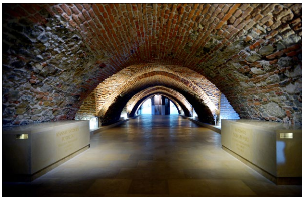
Ryc. 3. Podziemia pod bazyliką archikatedralną, widok w kierunku wschodnim na tzw. krypty gotyckie, za którymi znajduje się fundamentowa ściana rotundy; fot. D. Delmanowicz.
