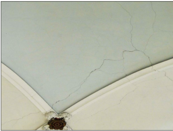
Ryc. 4. Spękania sklepień, 2018; fot. K. Ałykow. Fig. 4. Vault cracks, 2018; photo by K. Ałykow.
