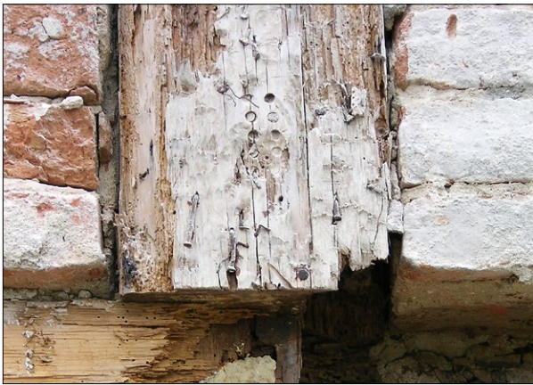
Ryc. 6. Rościszewice, kościół, północna nawa boczna, ściana północna, znak montażowy o kształcie okrągłym na słupie, rok 2009; fot. U. Schaaf.
