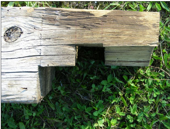
Ryc. 4. Rościszawice, kościół, fragment podwaliny z widocznymi śladami rylca i sangwiny, rok 2009; fot. U. Schaaf.
