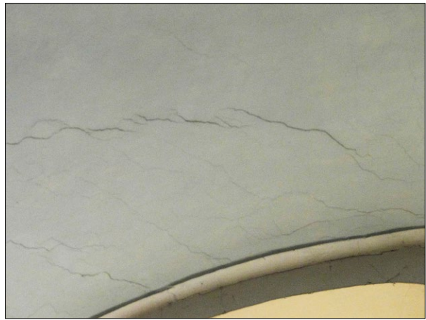
Ryc. 4. Spękania sklepień, 2018; fot. K. Ałykow. Fig. 4. Vault cracks, 2018; photo by K. Ałykow.
