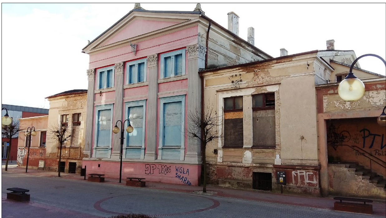
Ryc. 2. Kwidzyn, widok fasady dawnego kasyna i kina od strony północno-wschodniej, 2019; fot. Ł. Rzepczyński.
