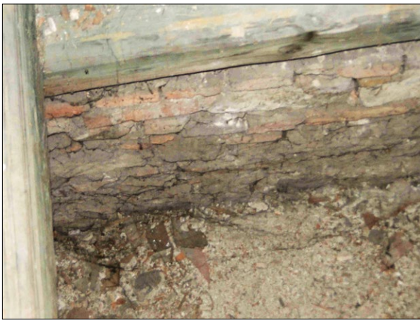
Ryc. 8. Nadmurowane filary na gurdzie sklepienia, 2018; fot. K. Ałtkow.
