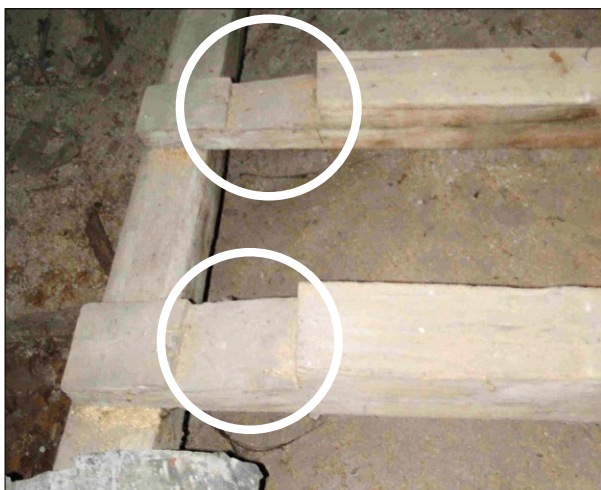
Ryc. 10. Brak oryginalnych elementów konstrukcji ciesielskiej, 2018; fot. K. Atykow.
