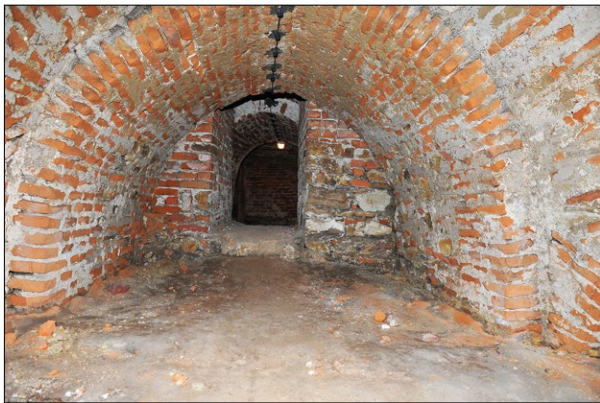
Ryc. 7. Widok podziemi bazyliki przed remontem, krypta pod północną nawą boczną; archiwum M. Piórkowskiego.
