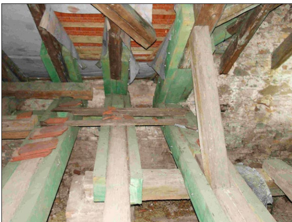
Ryc. 9. Naprawa więźby dachowej, 2018; fot. K. Ałtkow.
