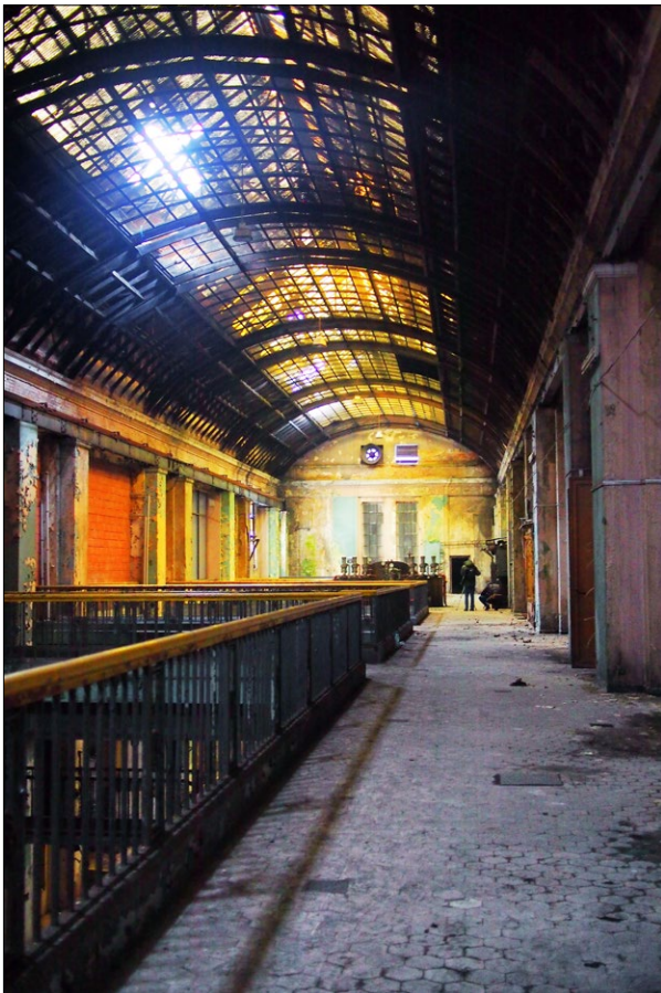
Ryc. 7. Hala maszyn pomocniczych nad pomieszczeniami pompowni; fot. D. Oleś 2019.
