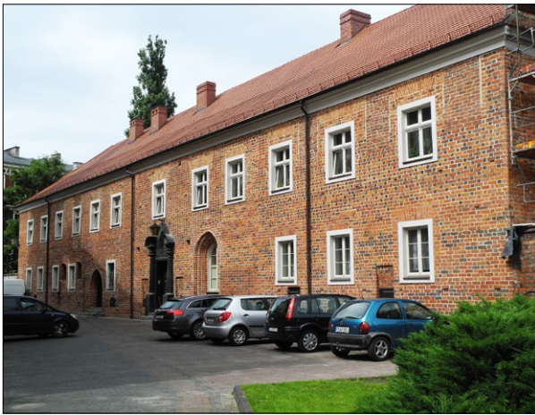
Ryc. 3. Kalisz, dawny klasztor kanoników laterańskich; elewacja południowa po pracach konserwatorskich; fot. M. Prarat 2018.
