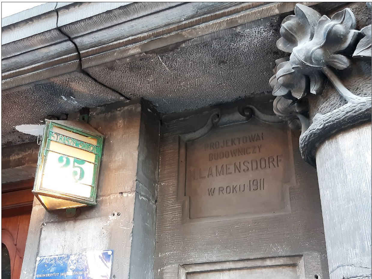
Ryc. 7. Ulica Straszewskiego 25, wciąż w pełni aktywna (podświetlana) „latarenka adresowa”, rok 2020; fot. W. Górny. Fig. 7. 25 Straszewskiego Street, still fully active (illuminated) “address lantern,” 2020; photo by W. Górny.
