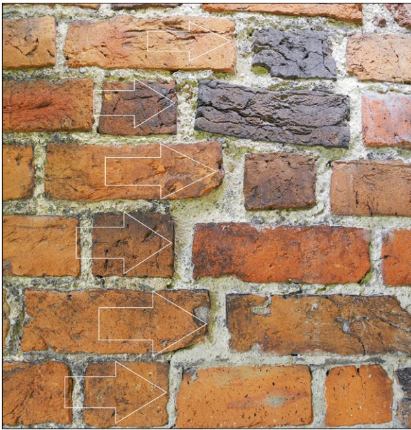
Ryc. 9. Kalisz, dawny klasztor kanoników laterańskich; elewacja północna, widoczne strzępiał pierwszej i drugiej fazy średniowiecznej; styk oznaczono strzałkami; fot. M. Prarat 2017.
