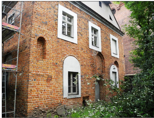
Ryc. 4. Kalisz, dawny klasztor kanoników laterańskich; elewacja zachodnia przed pracami konserwatorskimi; fot. M. Prarat 2016.
