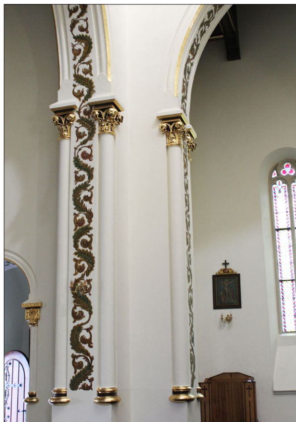
Ryc. 4. Filar międzynawowy, 2019; fot. M. Zub. Fig. 4. Inter-nave pier, 2019; photo by M. Zub.
