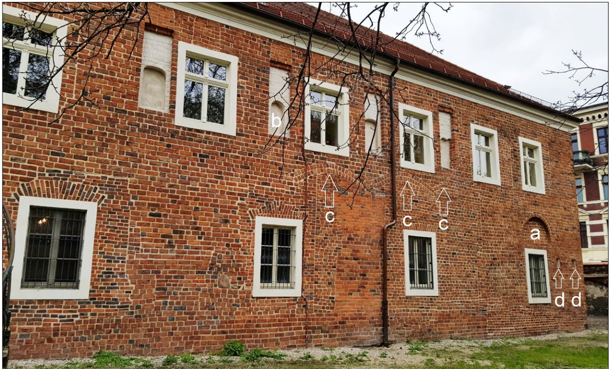
Ryc. 2. Kalisz, dawny klasztor kanoników laterańskich; część zachodnia elewacji północnej po pracach konserwatorskich; oznaczenia: a – pierwotna wnęka, b – pierwotny otwór okienny w blendzie, c – łuki pierwotnej artykulacji elewacji, d – gniazda po konstrukcji (zadaszenia?); fot. M. Prarat 2017.
