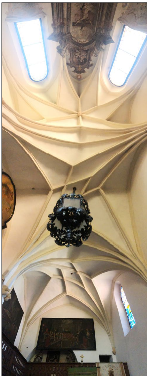
Ryc. 7. Kościół św. Bartłomieja, kaplica Oppersdorffów, sklepienie; fot. autor.
