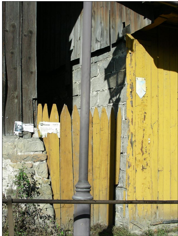
Ryc. 5. Dom przy ul. Świętokrzyskiej 7/109 (wpisany do Ewidencji Gminnej jako „drewniany o konstrukcji zrębowej, z 2 poł. XIX wieku, przebudowany”); widoczna ściana boczna z bloczków żużlobetonowych i pierwotne oszalowanie ściany frontowej ze znakiem tzw. błękitnej tarczy i z napisem „Zabytek chroniony prawem”; dom rozebrano rok temu; fot. T. Węclawowicz 2019.
