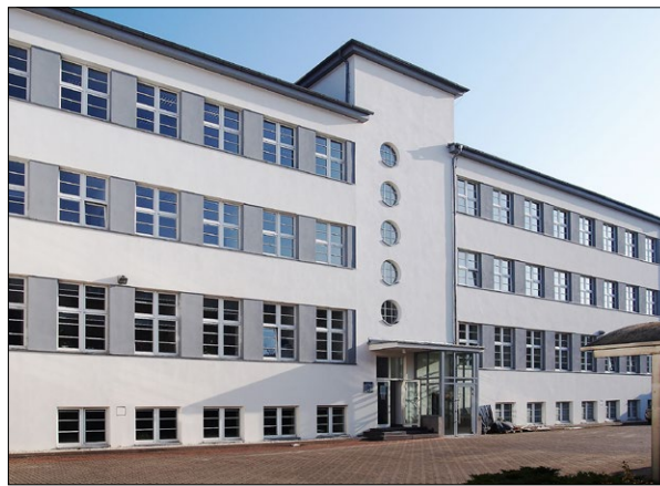
Ryc. 10. Fabryka Pebeco w Poznaniu, stan obecny, 2021; fot. autorka.
