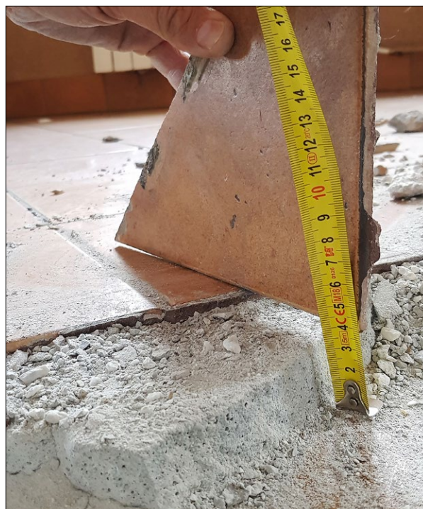
Ryc. 6. Zdjęcie jednej z odkrywek wykonanych w budynku nr 1 wraz z pomiarem grubości warstw posadzkowych; fot. autorzy.
