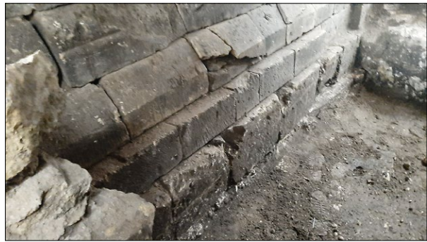
Ryc. 6. Zachowany fragment frontowej elewacji z ciosów kamiennych II romańskiej bazyliki Trójcy Świętej i Maryi Panny, wykop archeologiczny przy zachodniej elewacji kolegiaty w Wiślicy, rok 2020; fot. autorzy.
