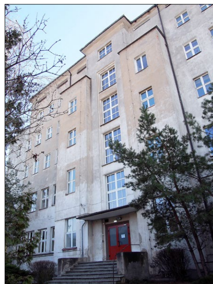
Ryc. 8. Internat Sióstr Urszulanek w Poznaniu, elewacja tylna, 2021; fot. autorka.
