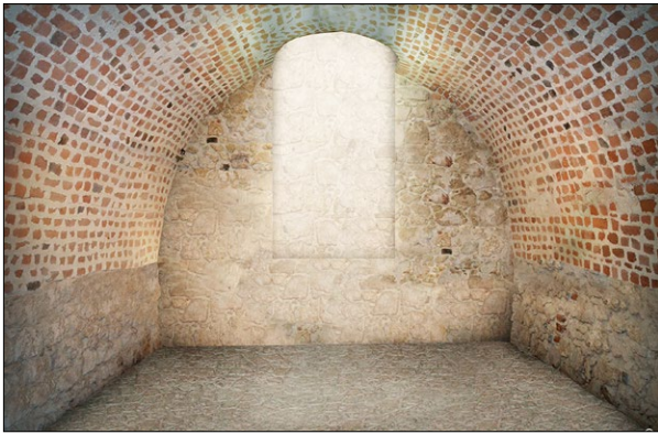
Ryc. 7, 8. Piwnice skrzydła wschodniego, łączącego dom Pęcherza z kurią Piotra Gerhardsdorfa, widok na ścianę wschodnią z oknem od ul. Jagiellońskiej. Stan obecny i wizja przeszłości; oprac. A. Kulig, J. Dziewoński.
