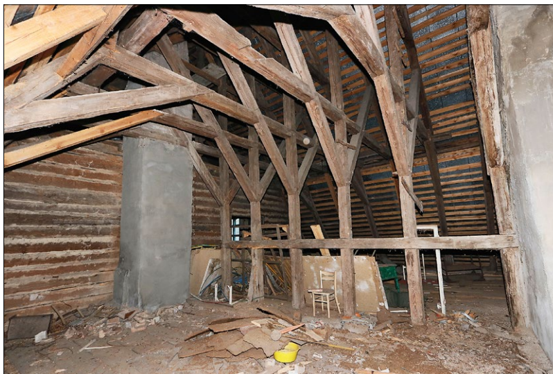
Ryc. 7. Więżba dachowa; fot. M. Warchoń 2020.
