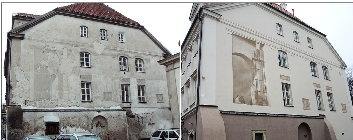
Ryc. 7. Kamienica przy ul. Freta 12, ściana szczytowa przed skuciem tynków oraz po narzuceniu nowych tynków i rekonstrukcji malowidła B.T. Urbanowicza; fot. T. Sawicki. Fig. 7. The tenement house at 12 Freta Street, the gable wall before plastering and after applying new plasters and reconstruction of the painting by B.T. Urbanowicz; photo by T. Sawicki.
