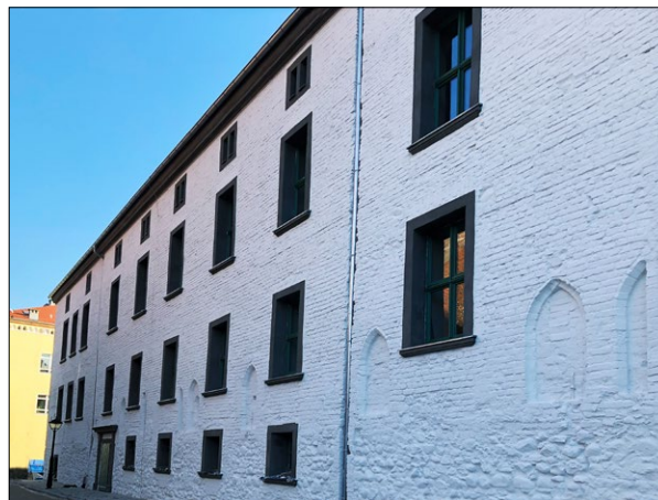
Ryc. 2. Dawny klasztor Magdalenek, widok od północnego zachodu, stan po pracach; fot. autor.
