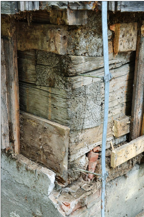
Ryc. 3. Odkrywka południowo-zachodniego węgła zrębu ścian zewnętrznych; fot. E. Zawaleń 2020.
