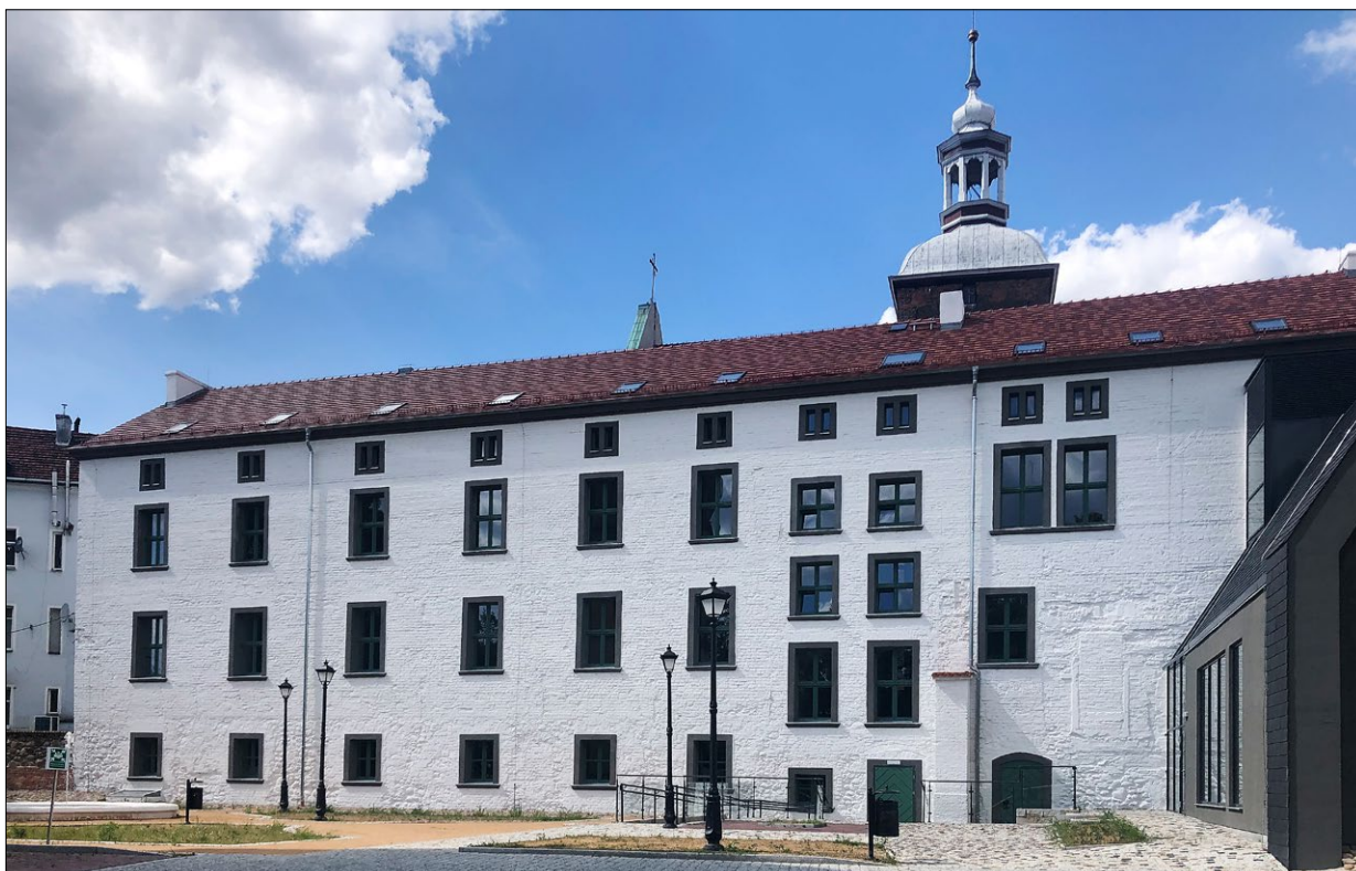
Ryc. 3. Widok od południa, stan po pracach; fot. autor.
