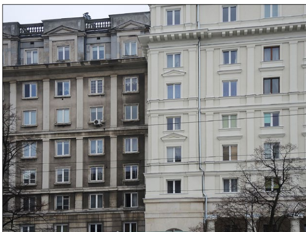
Ryc. 4. Budynek przy ul. Świętojskiej 24, elewacja od strony ul. Andersa, obok budynek niepoddany remontowi, rok 2020; fot. T. Sawicki.
