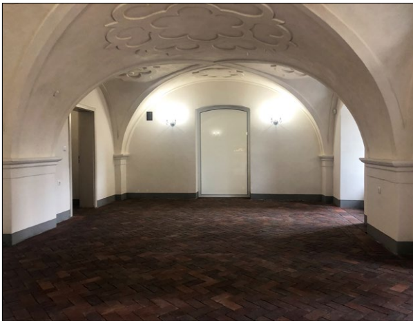
Ryc. 10. Parter, pasmo środkowe, wewnątrz sali barokowej traktu tylnego ku wschodowi, stan po pracach; fot. autor.
