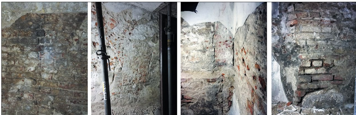
Ryc. 7. a) Widoczne strzępia w północnej ścianie pomieszczenia nr 1; b) skute łęki i filar sklepienny w zachodniej ścianie pomieszczenia nr 1; c) zewnętrzny narożnik muru pierwszej fazy (po lewej stronie), mur drugiej fazy (po prawej) i uzupełnienie należące do fazy czwartej; d) fundament muru pierwszej fazy; fot. autorzy.
