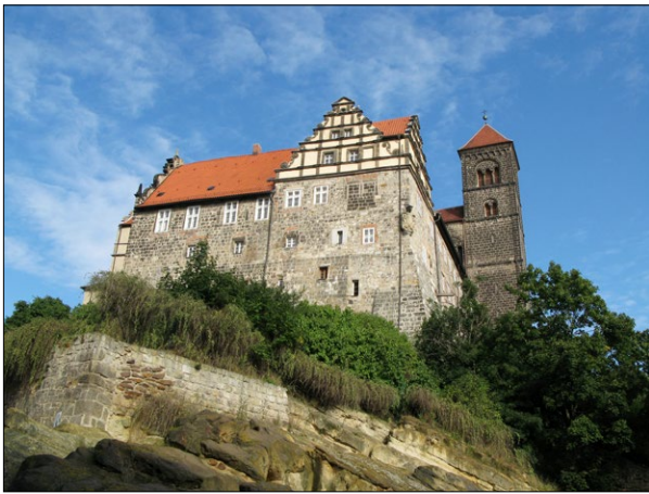
Ryc. 3. Widok na zamek – palatium królewskie od strony wschodniej; 2018.
