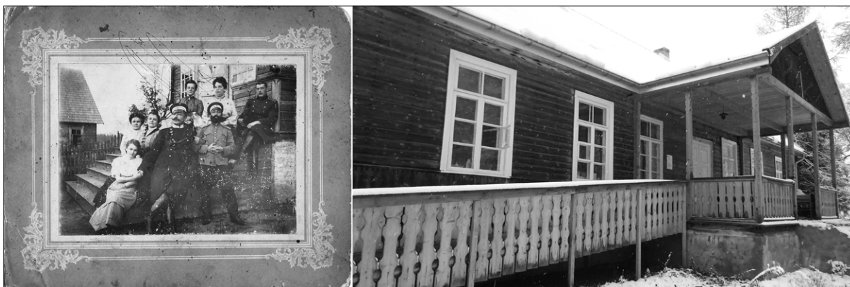
Ryc. 7. Widok na elewację z czasów przed 1914 oraz na główne wejście do obiektu w przybudówce wschodniej w 2021; fot. ze zbiorów właściciela oraz autorów.
