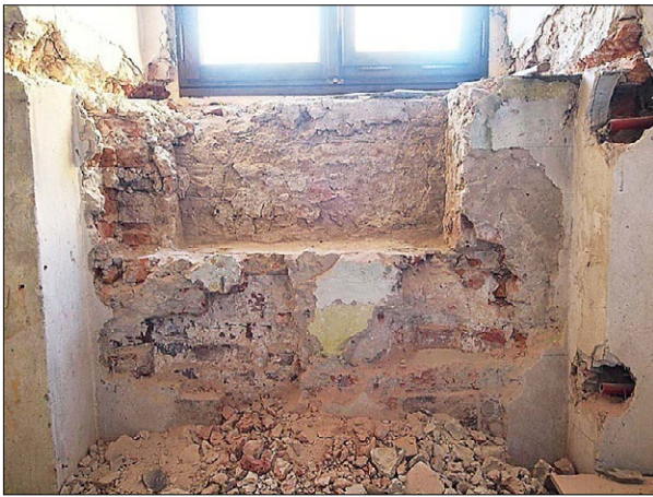
Ryc. 9. Sedilium odkryte w partii podparapetowej północnego okna: podczas eksploracji i po zakończeniu prac budowlanych, 2019; fot. A. Bojęś-Białasik.
