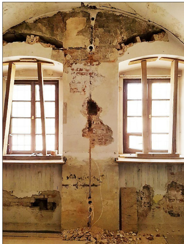
Ryc. 4. Para okien podczas odkrywania starszych nadproży – na podłuczcu lewego okna polichromia Salvator Mundi , 2018; fot. A. Bojęś-Białasik.
