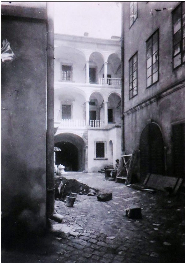
Ryc. 3. Dziedziniec Kamienicy Królewskiej, widok na oficynę i przearanżowane wejście z krużganków do Sali Reprezentacyjnej w trakcie prac rekonstrukcyjnych renesansowych krużganków wg projektu architekta L. Giurkovicza, ok. 1926–1927; źródło: Пам'ятка архітектури 1977, справа Л-69-9
