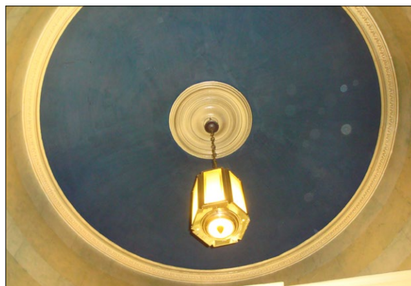
Ryc. 4. Sufit z charakterystycznym gzymszem w pomieszczeniu toalety, przed demontażem, 2018; fot. R. Jeżowski
