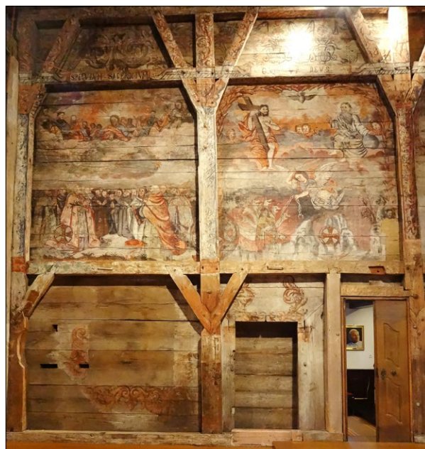
Ryc. 4. Odrestaurowana polichromia na zrębie i konstrukcji szkieletowej północnej ściany prezbiterium, 2022; fot. autorka
