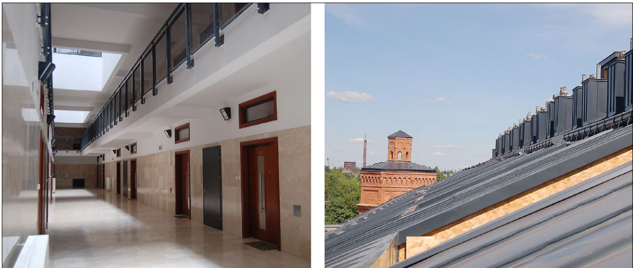
Ryc. 2. Części komunikacji wewnątrz budynku przędzalni, widok dachu budynku z widocznymi instalacjami; fot. B.M. Walczak
