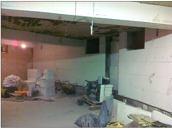
Fig. 7. Insulation on the interior of the exterior walls and the terrace above the basement, 2012; photo by P. Opalka Ryc. 7. Ocieplenie po wewnętrznej stronie ścian zewnętrznych i tarasu nad piwnicą, 2012; fot. P. Opalka
