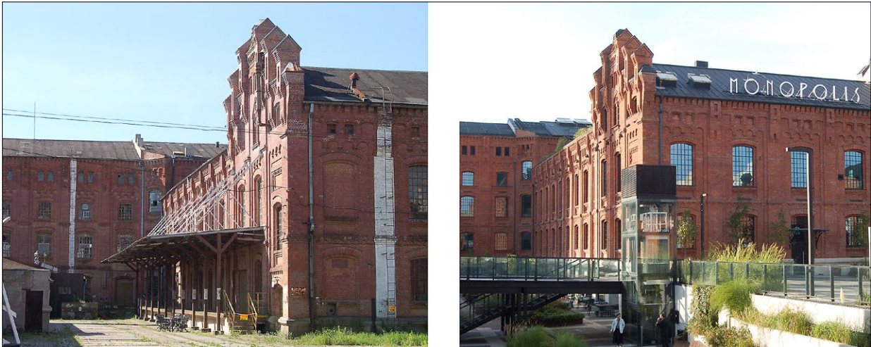
Ryc. 1. Plac wewnętrzny zakładu przed realizacją i po realizacji, widoczna ingerencja w postaci wykopu w celu wprowadzenia dodatkowej kondygnacji; fot. B.M. Walczak
