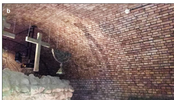
Ryc. 5. Gruba Kochanowicza; a) mury, b) sklepienie, 2021; fot. K. Sikorski
