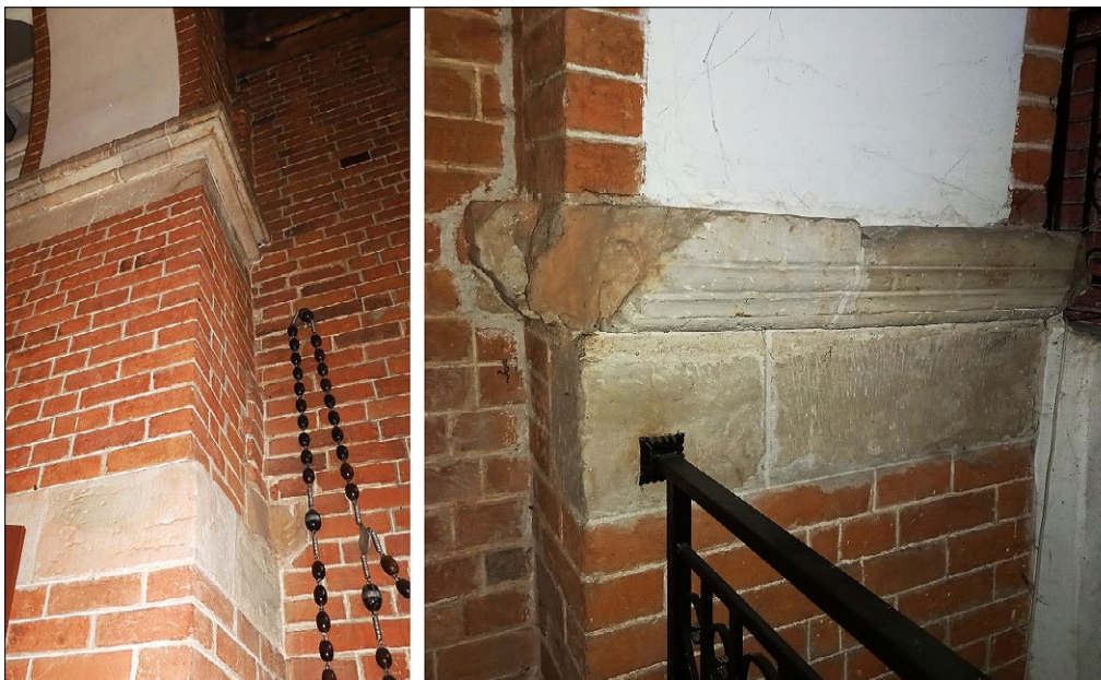
Ryc. 5. Półfilary arkad południowych: 5.1 – półfilar wschodni, 5.2 – półfilar zachodni, 2022; fot. M. Doroz-Turek Fig. 5. Half-pillars of the southern arcades: 5.1 – eastern half-pillar, 5.2 – western half-pillar, 2022; photo by M. Doroz-Turek
